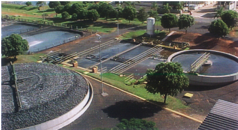
Foto 11 - Estação de Tratamento de Esgoto (ETE).
