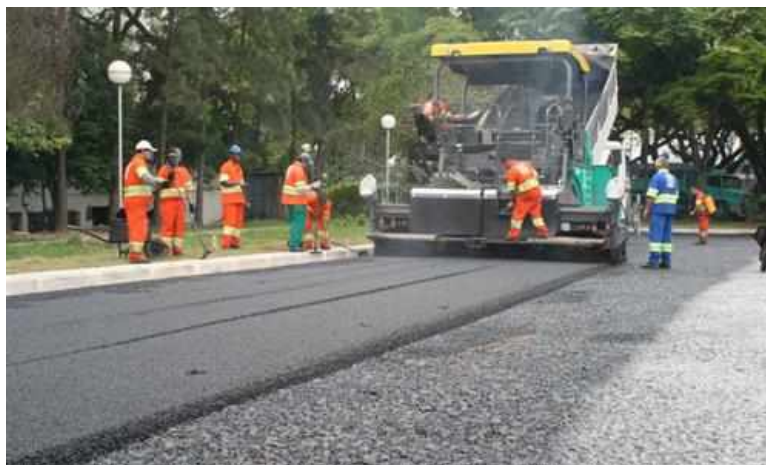
Figura 5 - Implementação de pavimento permeável na cidade de São Paulo
