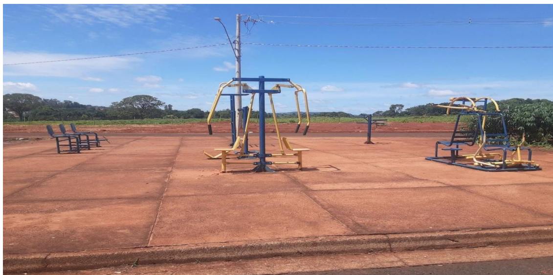
Figura 35: O estado de uma área de lazer no Bairro Nadime Derze
