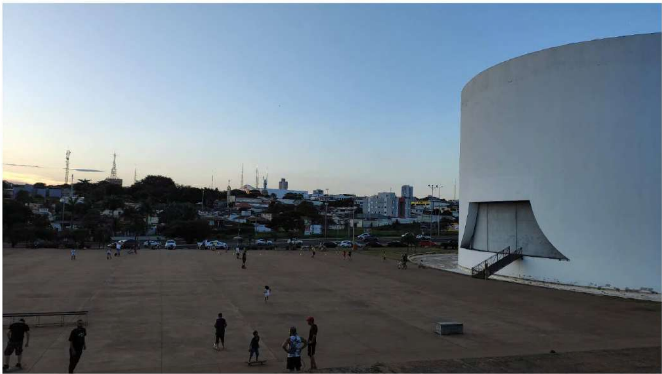
Figura 59. Área da intervenção
