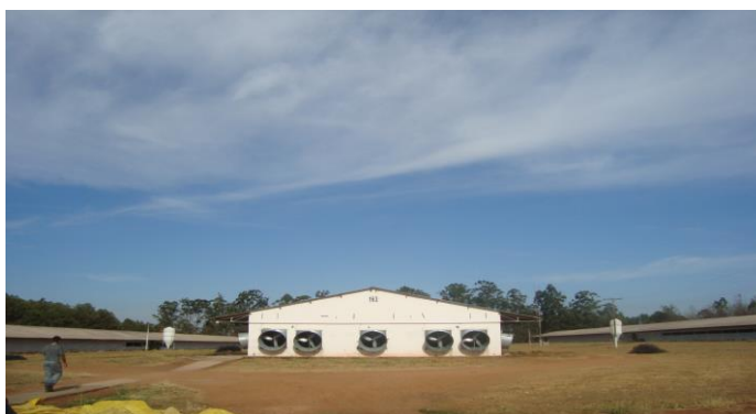
Figura 1. Vista do Núcleo de matrizes
