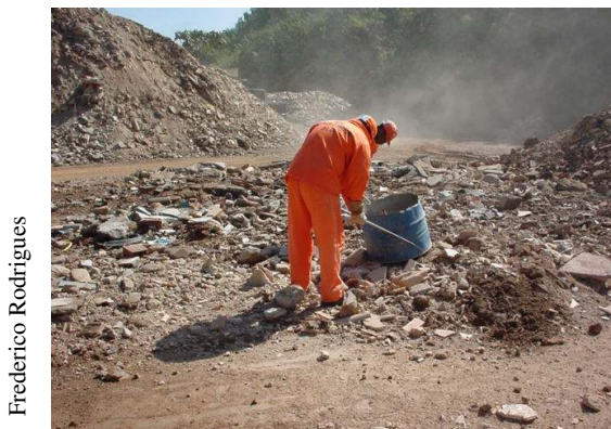
Figura 2.6 – Triagem manual dos resíduos
