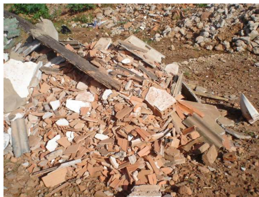
Figura 4.38 – Resíduos de obra de demolição presentes na Caçamba 1
