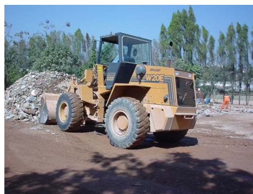
Figura 2.9 – Transporte por pá-carregadeira
