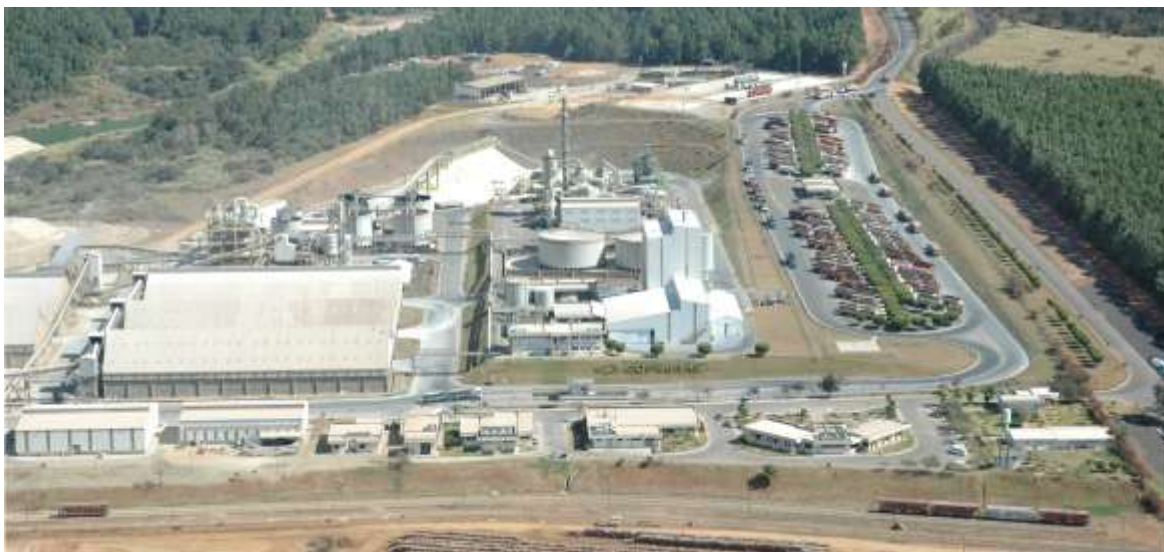
Foto 5 – Vista aérea da Copebrás S.A. Autor: ALVARENGA, R., 2008.
