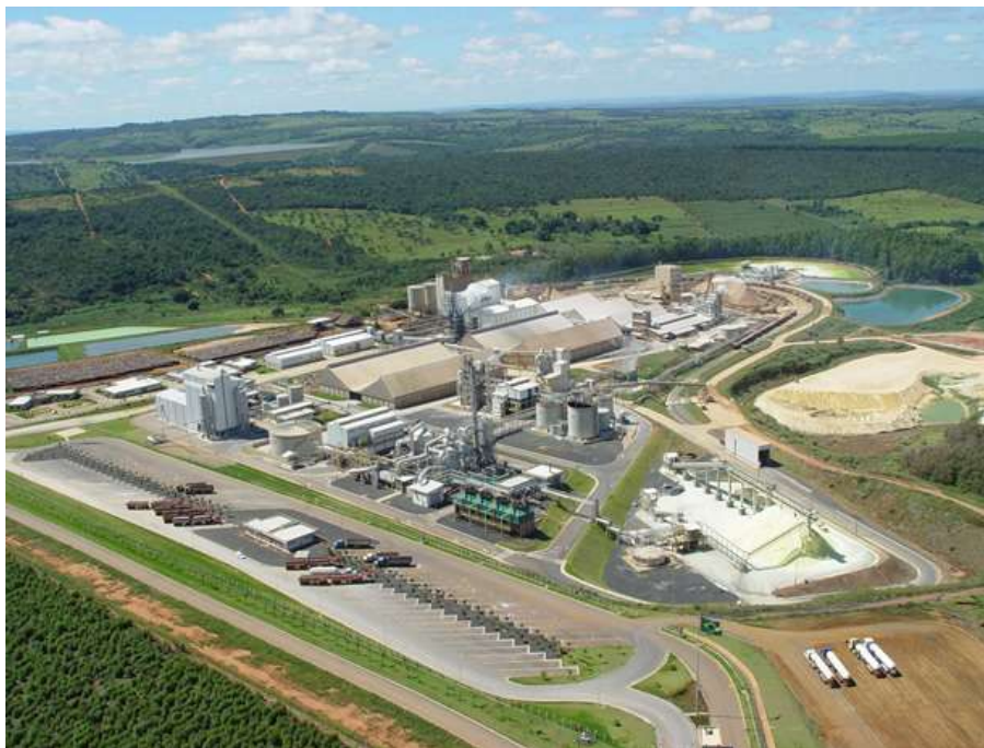
Foto 1 – Vista aérea da Copebrás S.A Autor: ALVARENGA, R. 2004.
