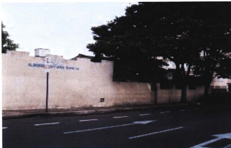
Área externa do Albergue (fachada)
