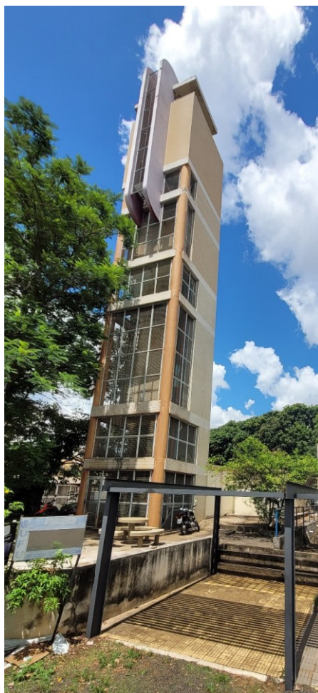
Figura 6 - Reservatório central de distribuição - Reservatório castelo.
