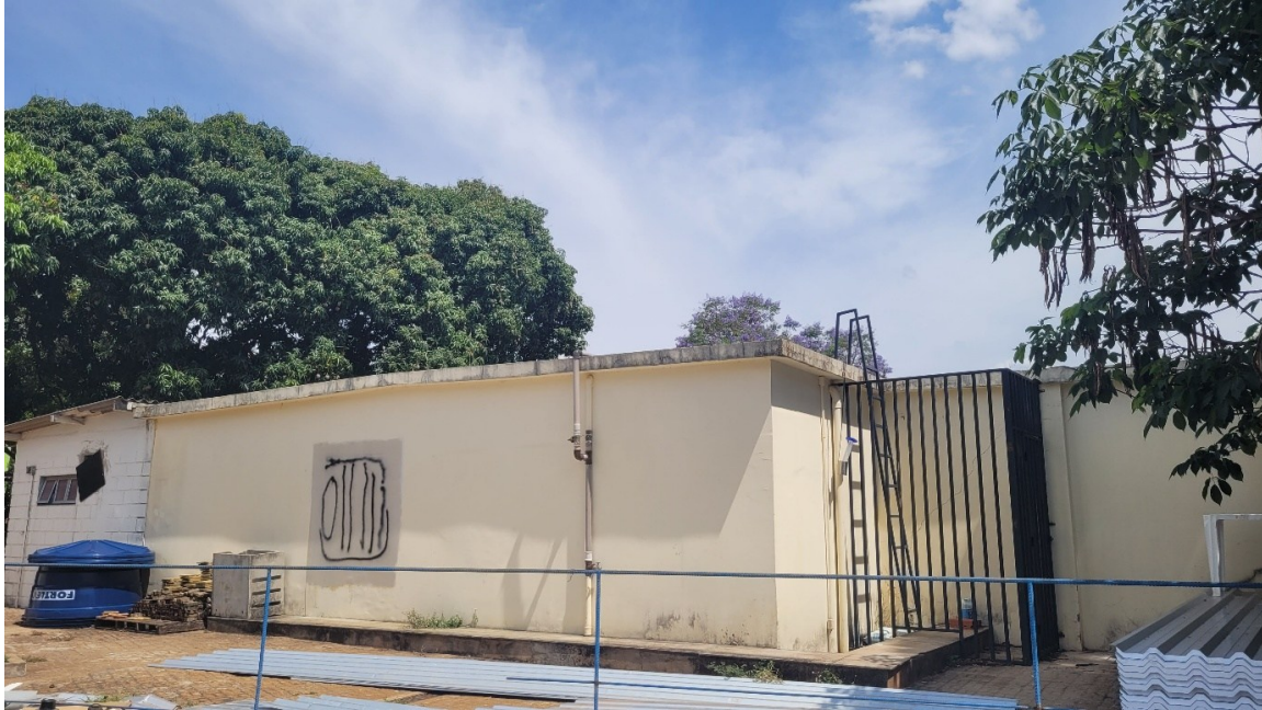
Figura 5 - Reservatório central de distribuição - Reservatório inferior.
