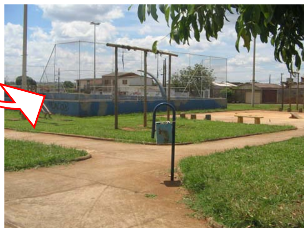
Foto 11 – Praça ‘H10’: Precários equipamentos de diversão e bancos danificados. Autor: Teobaldo Neto 28/09/2006
