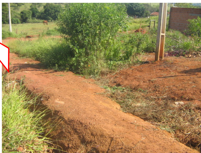
Foto 3 – Rua em encosta com declividade superior a 15%, ângulo oposto à foto 2. (Fonte: Teobaldo Neto – 28/05/2006)
