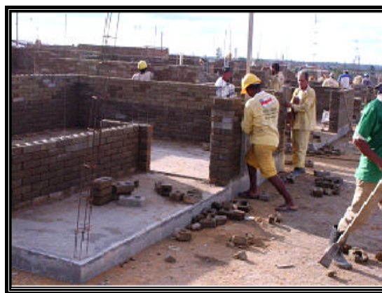
Figura 4.9 – Conferindo o prumo da alvenaria de solo-cimento.
