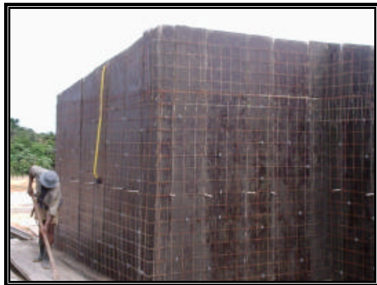
Figura 1.3 - Parede em concreto celular armada.
