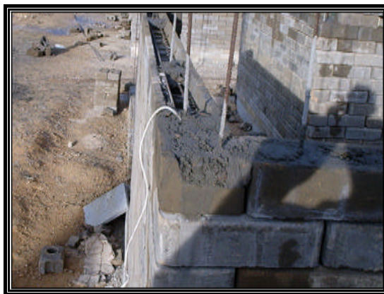
Figura 4.12 – Detalhe da concretagem da primeira cinta.
