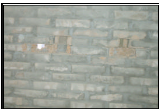
Figura 6.10 – Traspassamento da parede de solo-cimento rejuntada – parede interna.
