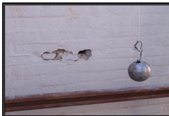
Figura 6.11 – Traspassamento da parede de solo-cimento rejuntada – parede externa.
