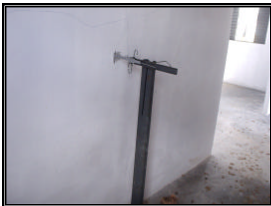
Figura 5.12 – Colocação do paquímetro para registrar os deslocamentos.
