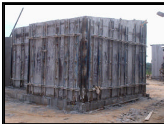
Figura 4.18 – Detalhe das formas das casas de concreto celular.
