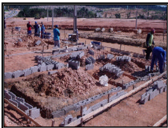
Figura 4.3 – Vista geral da fundação em bloco de concreto estrutural.
