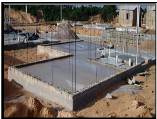
Figura 4.6 – Detalhe da primeira fiada.
