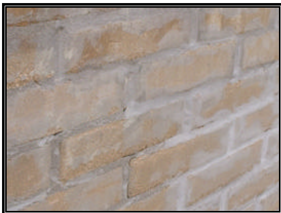
Figura 1.1 – Parede de solo-cimento rejuntada.
