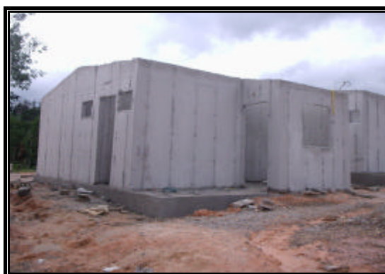
Figura 4.21 – Irregularidades das paredes após a desfôrma.
