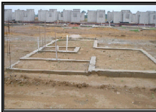
Figura 4.16 – Fundação de uma casa em concreto celular.
