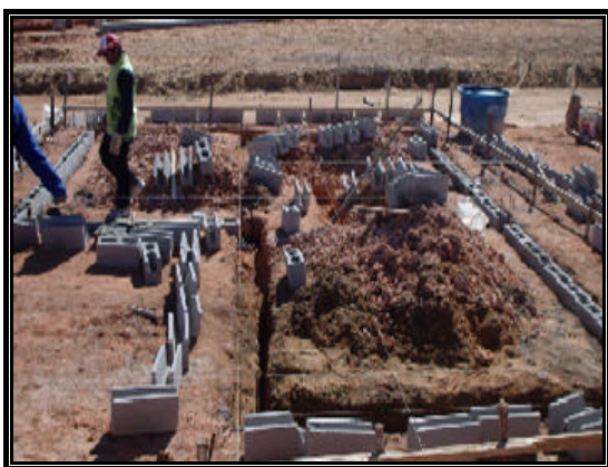
Figura 4.1 – Detalhe da execução da locação.
