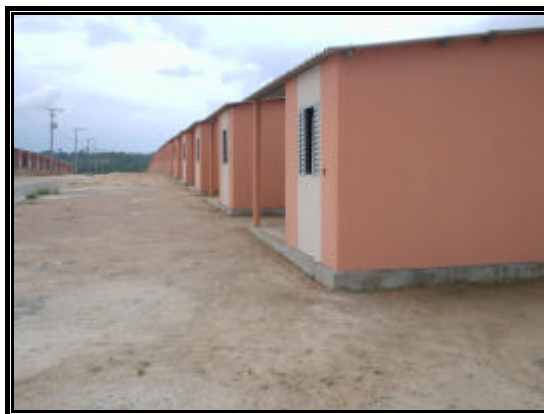
Figura 4.22 – Casas em concreto celular pronta para serem entregue à população.
