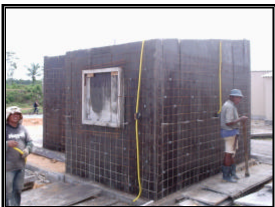
Figura 4.17 – Detalhe das telas de aço e instalações elétricas nas paredes.
