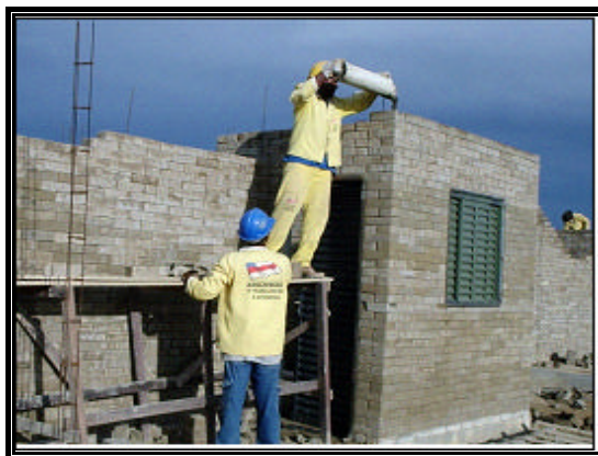
Figura 4.11 – Preenchimento dos furos dos tijolos com concreto.
