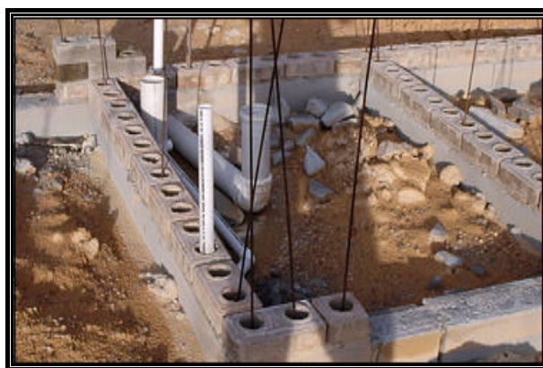
Figura 4.5 – Instalações hidro-sanitárias.
