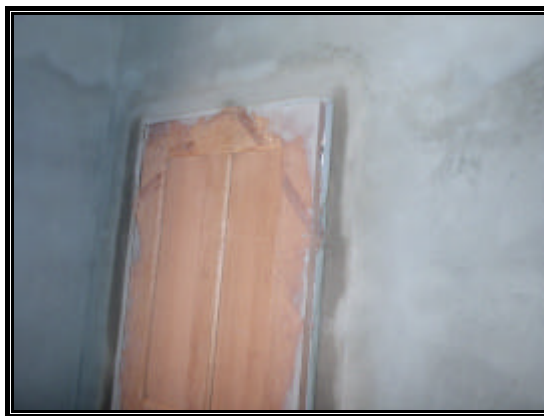
Figura 6.17 – Detalhe da alvenaria de solo-cimento rebocada após o ensaio de interação entre paredes e portas.
