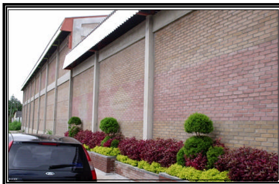
Figura 3.4 – Galpão industrial em tijolos de solo-cimento.
