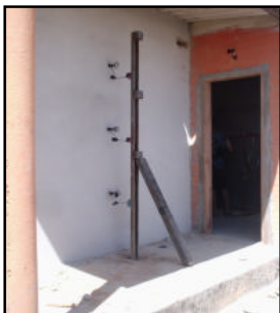
Figura 6.14 – Relógios comparadores colocados na parede para medir deslocamento.
