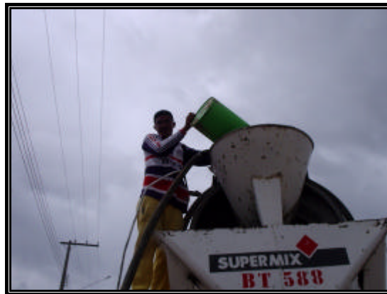
Figura 4.20 – Adição do material espumígeno e do super-fluidificante.
