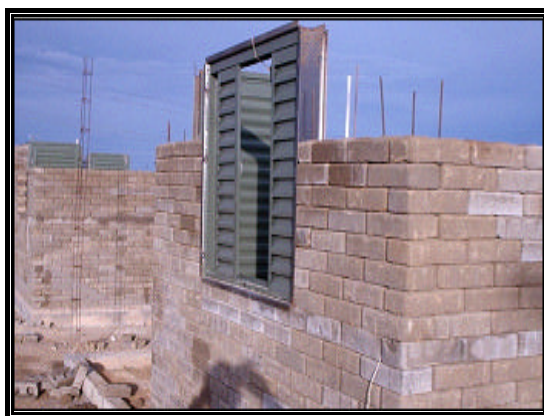
Figura 4.13 - Assentamento das esquadrias.
