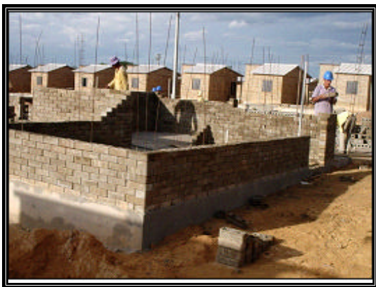
Figura 4.8 – Assentamento dos tijolos de solo-cimento.
