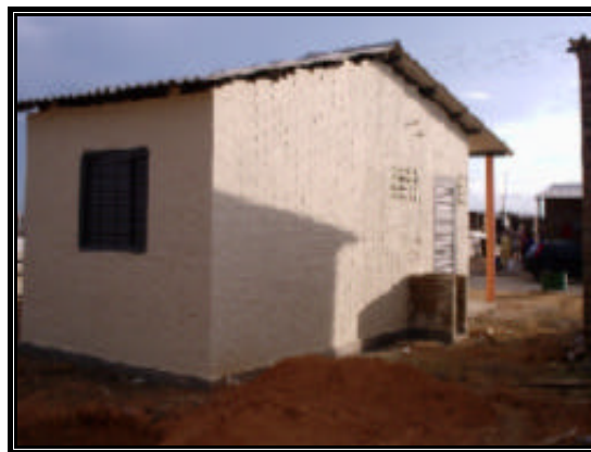
Figura 4.15 – Cobertura das casas em duas águas.
