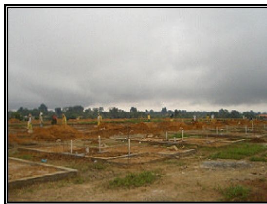
Figura 4.2 – Terreno com fundações locadas.
