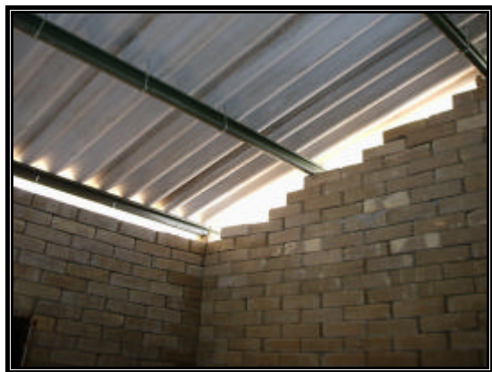
Figura 4.14 – Detalhe da estrutura metálica da cobertura em perfil C.
