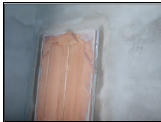
Figura 1.2 – Parede de solo-cimento rebocada.
