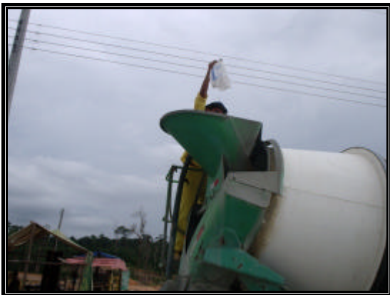
Figura 4.19 – Adição de fibras de polipropileno no caminhão betoneira.
