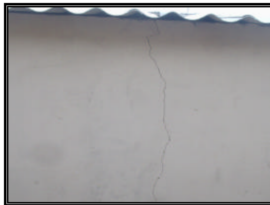
Figura 5.9 – Abertura numa residência de concreto celular parcialmente armado.
