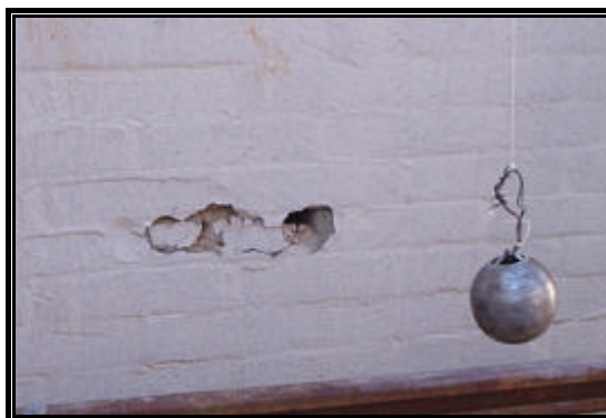
Figura 5.29 – Falha na parede de solo-cimento rejuntada devido ao ensaio de impacto de corpo duro
