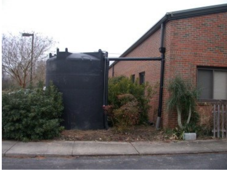
Figura 2 - Reservatório de água pluvial exposto no condado de Craven, na Carolina do Norte, Estados Unidos.
