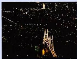
Destaque da ponte Hercílio Luz, Florianópolis (SC).
