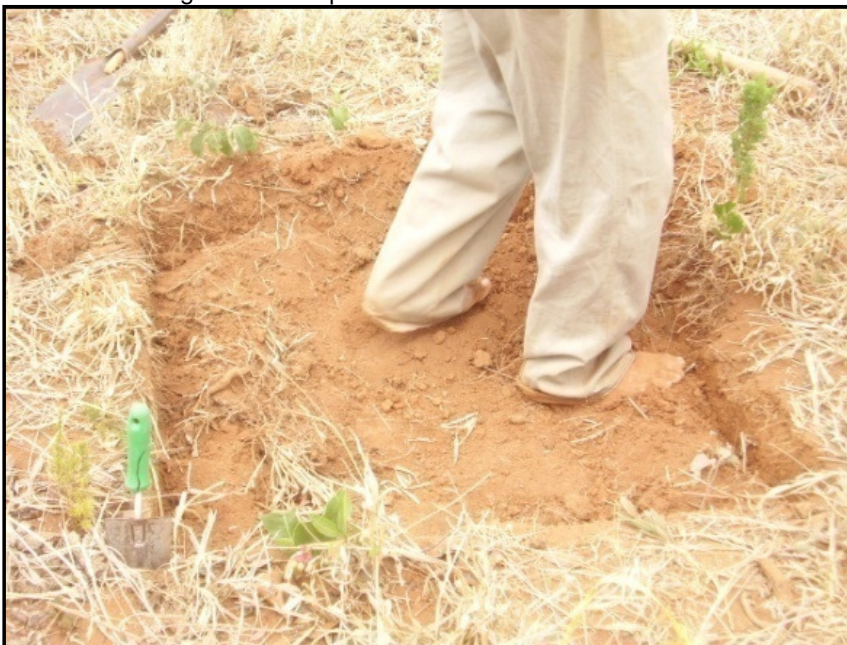
Autora: Roselir Nascimento, 2007. Foto 09 – Início da escavação da trincheira.
