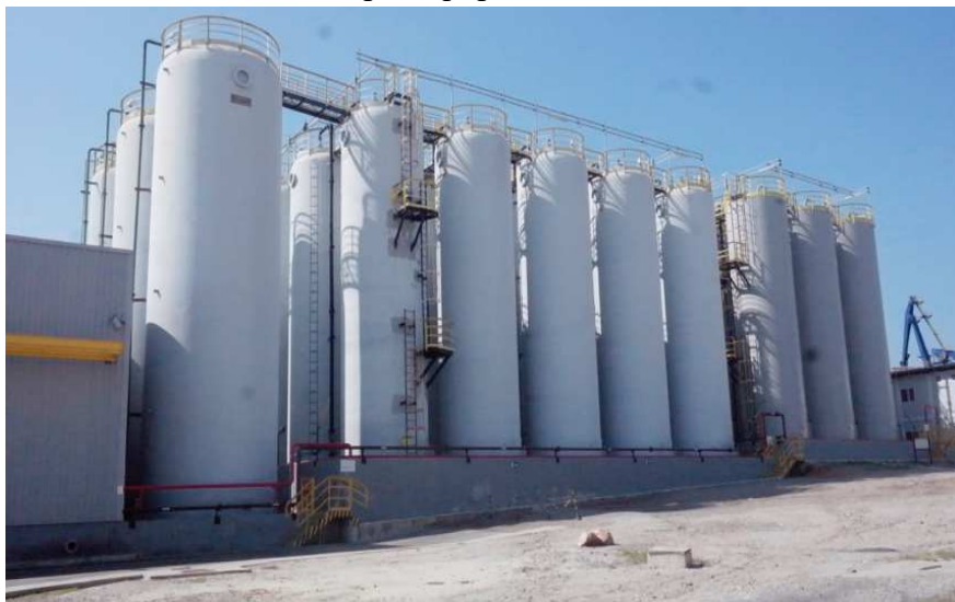
FIGURA 11 - Exemplo equipamento industrial em PRFV.
