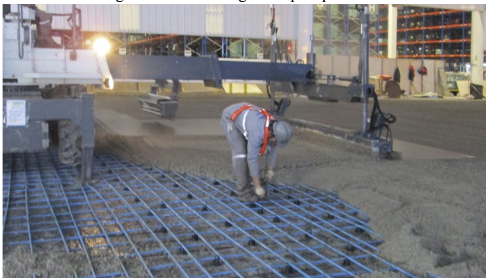
Figura 39 - Concretagem de piso protendido
