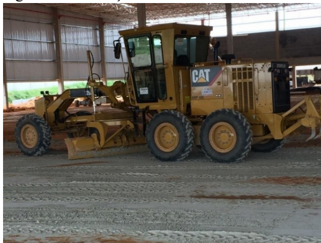
Figura 21- Execução de sub-base de solo-cimento
