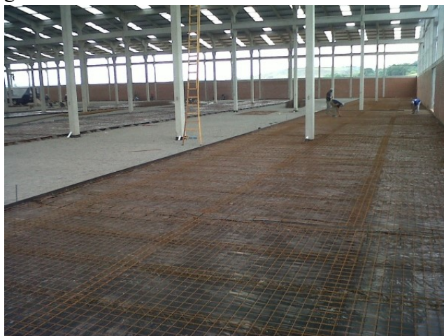
Figura 33- Piso de concreto com armadura distribuída
