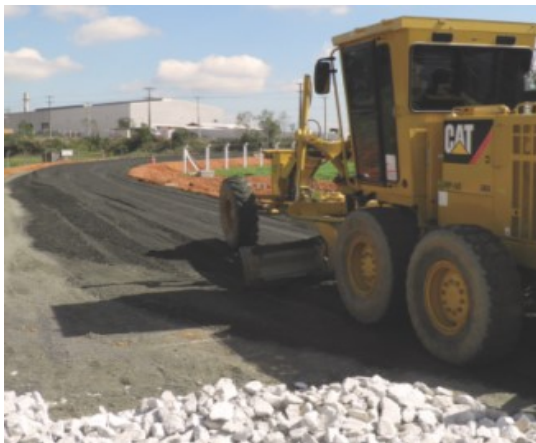
Figura 18- Execução de sub-base granular
