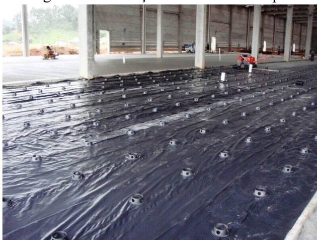
Figura 24- Execução da barreira de vapor
