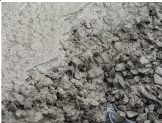
Figura 37 - Detalhe do concreto com fibras de aço
