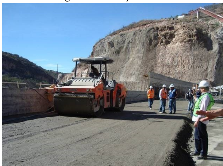
Figura 22- Execução de CCR
