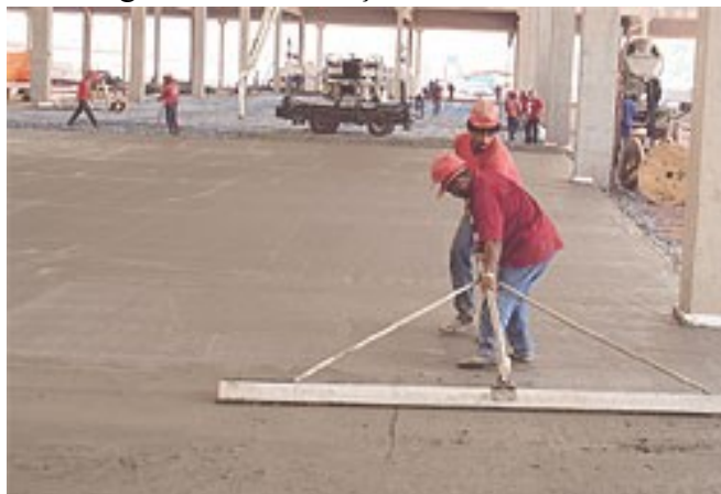
Figura 27 – Utilização do rodo de corte
