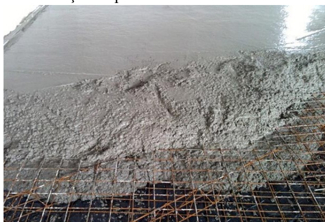
Figura 35- Execução de piso de concreto estruturalmente armado
