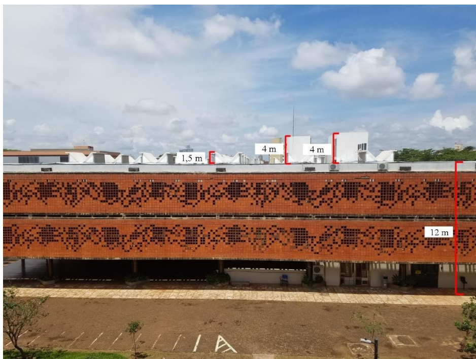
Figura 11 – Lateral da biblioteca UFU campus Santa Mônica, com as estimativas de altura [Autor].
