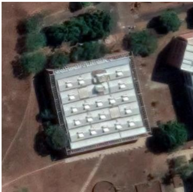
Figura 9 - Estrutura do telhado da Biblioteca UFU Santa Mônica vista superior [13].
