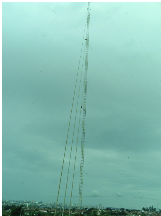
Figura 1.1: Torre estaiada de 102m.
