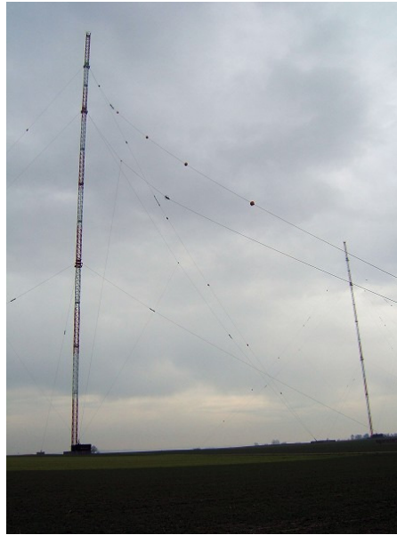
Figura 2.2: Mastros estaiados em aço 3 .
