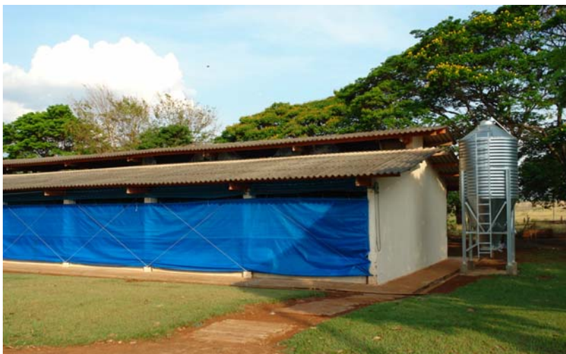
Figura 5: galpão dos frangos de corte Autora: Nehme, V. G. F.
