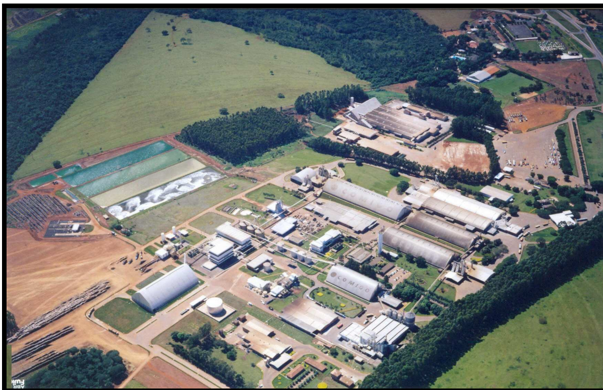
FOTO 4 – Rio Verde: Vista aérea do Complexo Industrial da COMIGO
