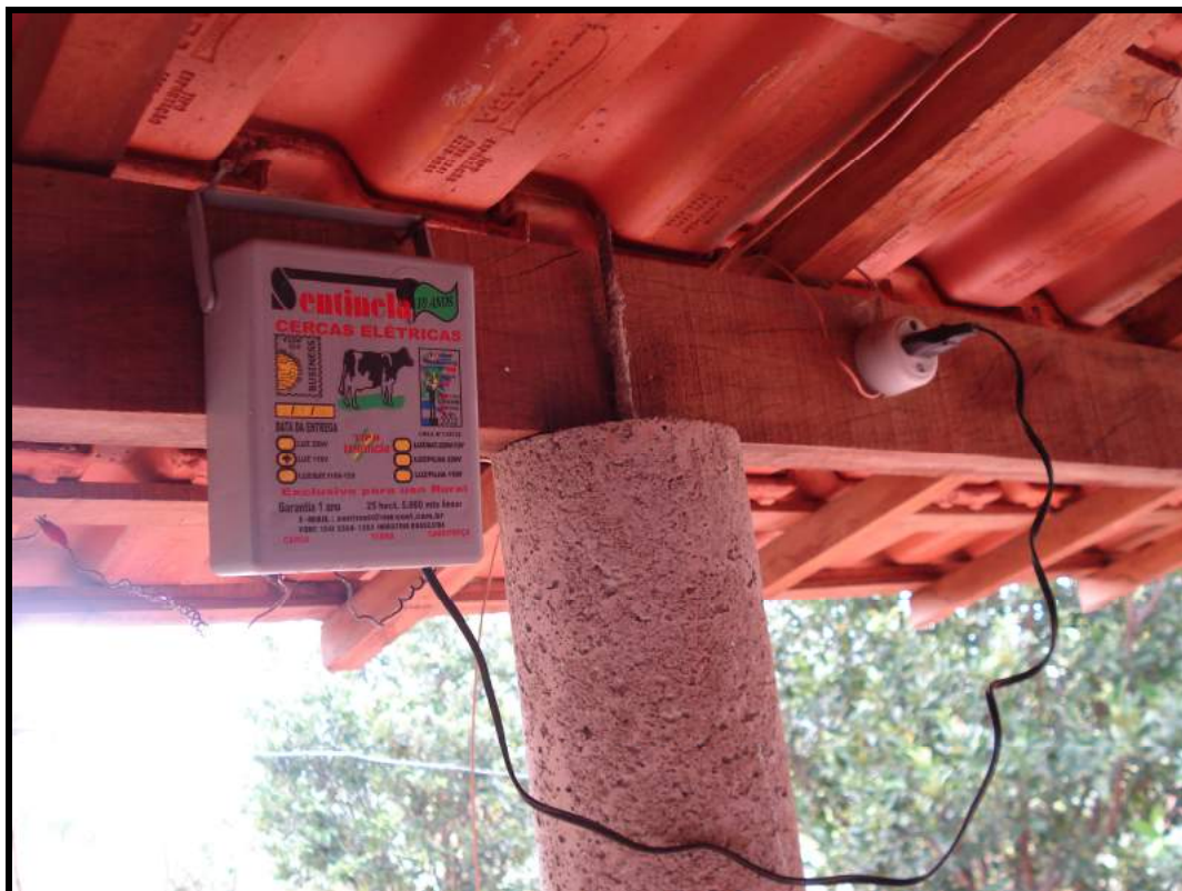
Foto 2: Aparelho transmissor de energia elétrica para as cercas divisoras da pastagem em piquetes. O aparelho está instalado na residência do morador do lote nº 02. Autor: CRUZ, Nelson Ney Dantas, março de 2007.
