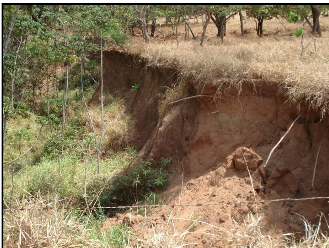
Foto 3: Erosão do solo em área de nascente d'água, situada nas margens do córrego Divisa. Essa área é acessada pelo rebanho bovino do lote nº 22. Autor: CRUZ, Nelson Ney Dantas, setembro de 2007.
