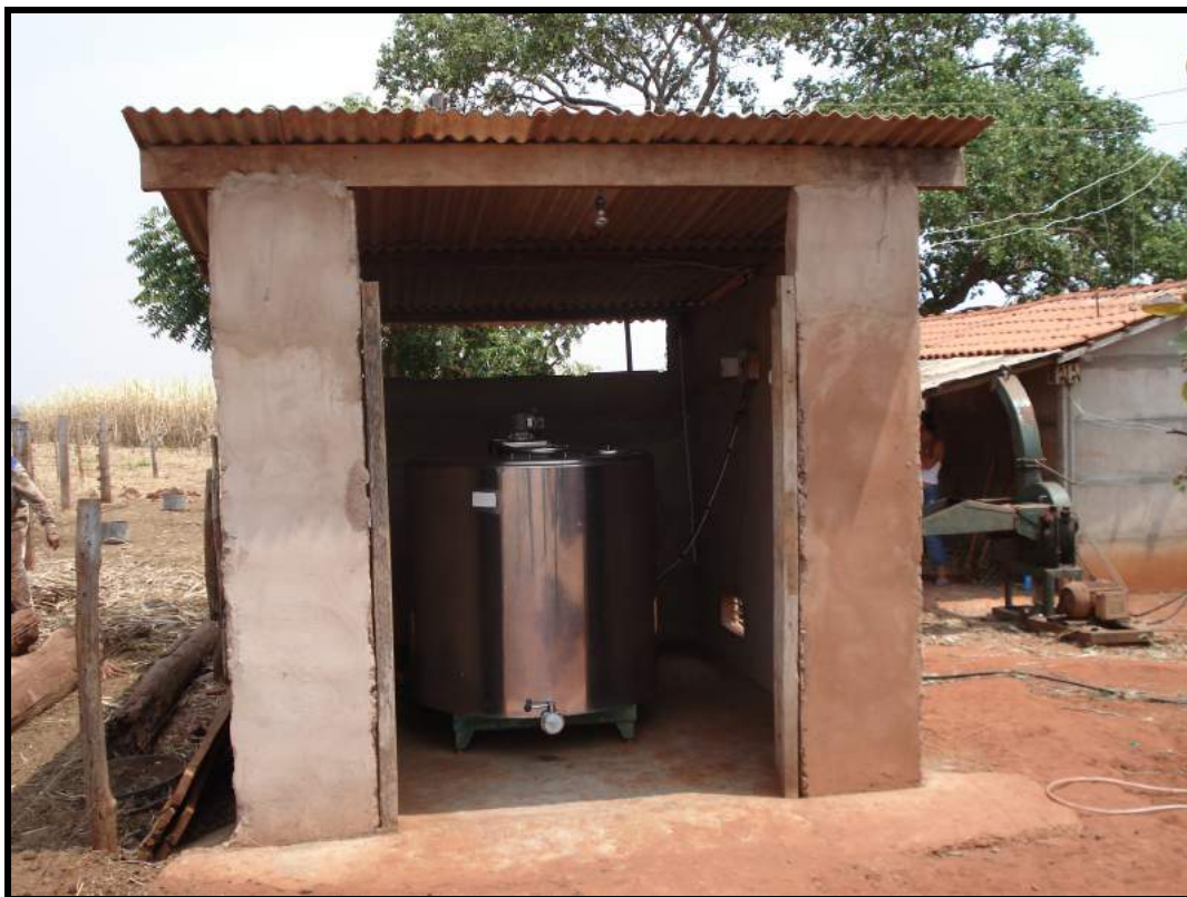
Foto 4: Tanque de expansão para armazenamento de leite, localizado no lote nº 07. Os laticínios da cidade exigem que o leite seja armazenado em tanques de resfriamento. A alternativa dos produtores é se organizar em grupos e adquirir o equipamento por meio de compra. Autor: CRUZ, Nelson Ney Dantas, Setembro de 2007.
