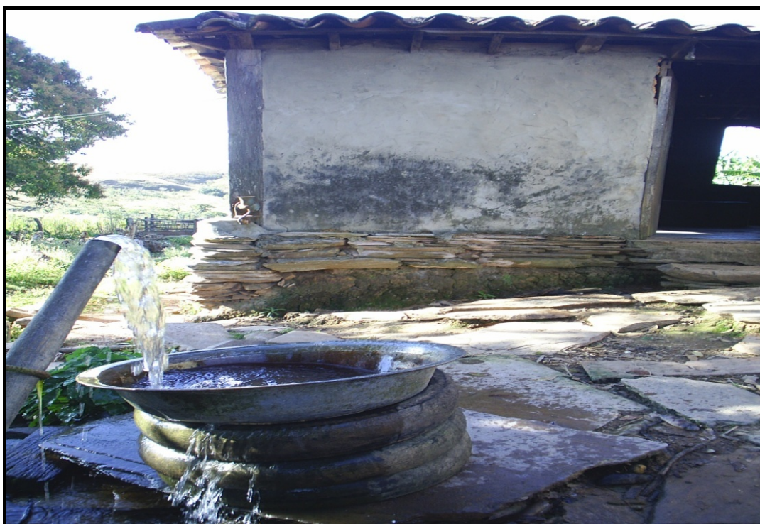
Figura 14: Casario abandonado nas imediações do distrito de Desemboque, revela uma realidade constatada no município, um número muito grande de propriedades abandonadas causadas pela migração para as cidades. Este abandono reside no fato de que o sustento da família se tornou difícil nestas fazendas e em busca de outro tipo de vida para os filhos, deixam as casas. Que tipo de turismo podemos pensar para este lugar, ai está uma grande oportunidade da efetivação do planejamento turístico, transformando estes lugares abandonados em receptivo típico e trazendo o morador de volta. Conhecemos na região de Serro - MG, um projeto desenvolvido pela gestão pública em parceria com o Senai está revitalizando o espaço rural através de incentivos para trazer o morador de volta e foram significativos os resultados como a produção do queijo serro. Assim é necessário pensar em uma proposta integrada de turismo isso pode resgatar dos valores locais. Fonte: CEZAR, T. (2006).
