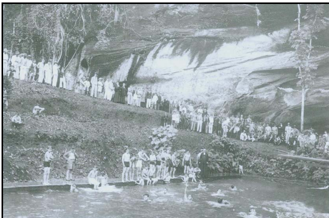
Figura 18: Comparando esta imagem com a figura 17, observamos que as alterações foram significativas provocadas na gruta dos Palhares, o fato de maior destaque está no rebaixamento do nível da base que chegou a 5 metros. Fonte: CERCHI, C. (1998).
