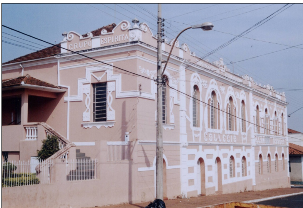
Fig. 31. Colégio Allan Kardec, um dos mais importantes representantes dos bens arquitetônicos do município. Apesar da sua importância como patrimônio arquitetônico, cultural e histórico, o prédio não possui qualquer proteção e vem sofrendo alterações com o passar dos anos. Existe resistência ao tombamento por parte dos dirigentes da fundação responsável pelo prédio, e das autoridades municipais.
