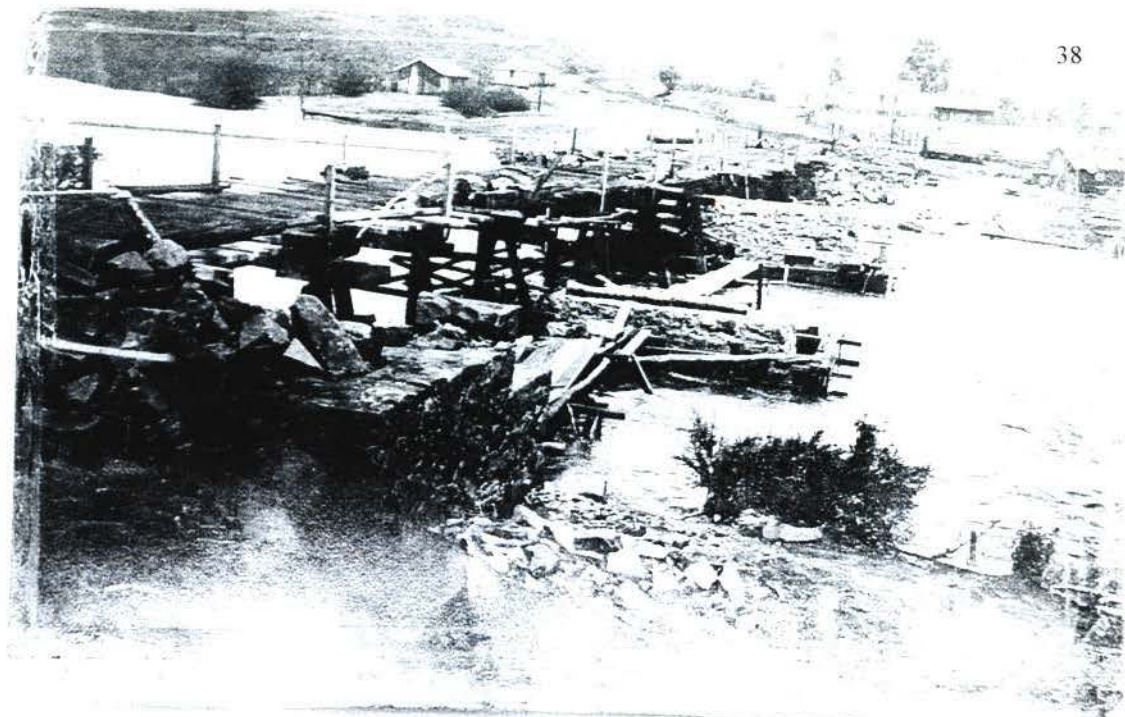
Ponte do Marquinho em construção
