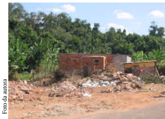
Figura 4.31 – Invasão da área – casa dos “sem-teto”.
