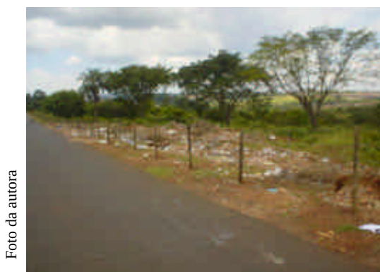
Figura 4.42 – Antiga CE -Volume do entulho em 16/02/2005.
