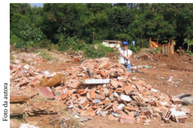
Figura 4.64 – RCD com blocos cerâmicos inteiros.
