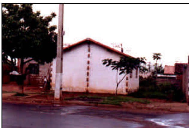
Figura 4.3 – Bairro Tocantins: casa original do conjunto ainda preservada, 2002.
