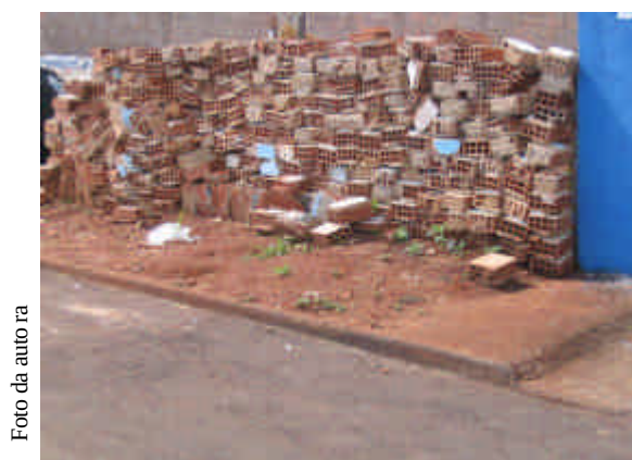
Figura 4.63 – Muro feito com entulho.
