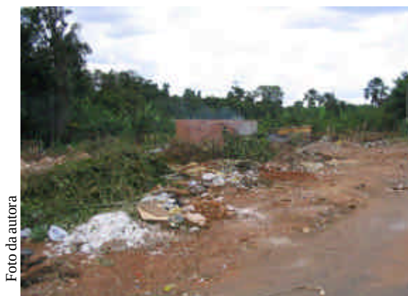
Figura 4.12 – Entulho e resíduos diversos na área do PC Tocantins – 14/02/05.
