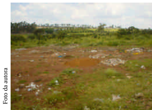
Figura 4.36 – Extinta CE invadida com deposição no Bairro Guarani -16/02/05.
