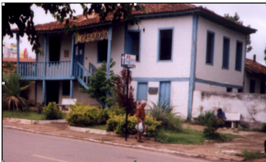
Figura 17 - Casarão, construção do final do século XIX, Caldas Novas (GO), 2004. Autor: BORGES, O. M. , 2004.
