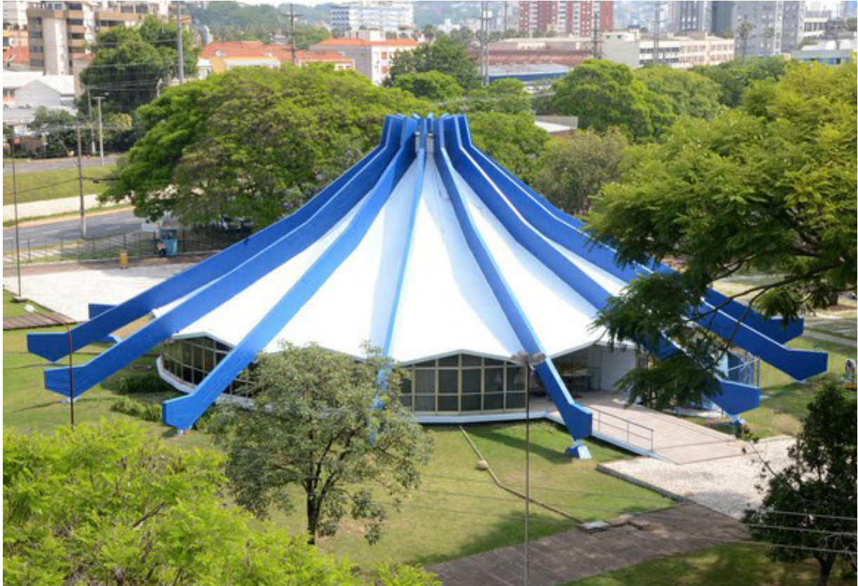
Figura 1: Prédio do Planetário da UFRGS
