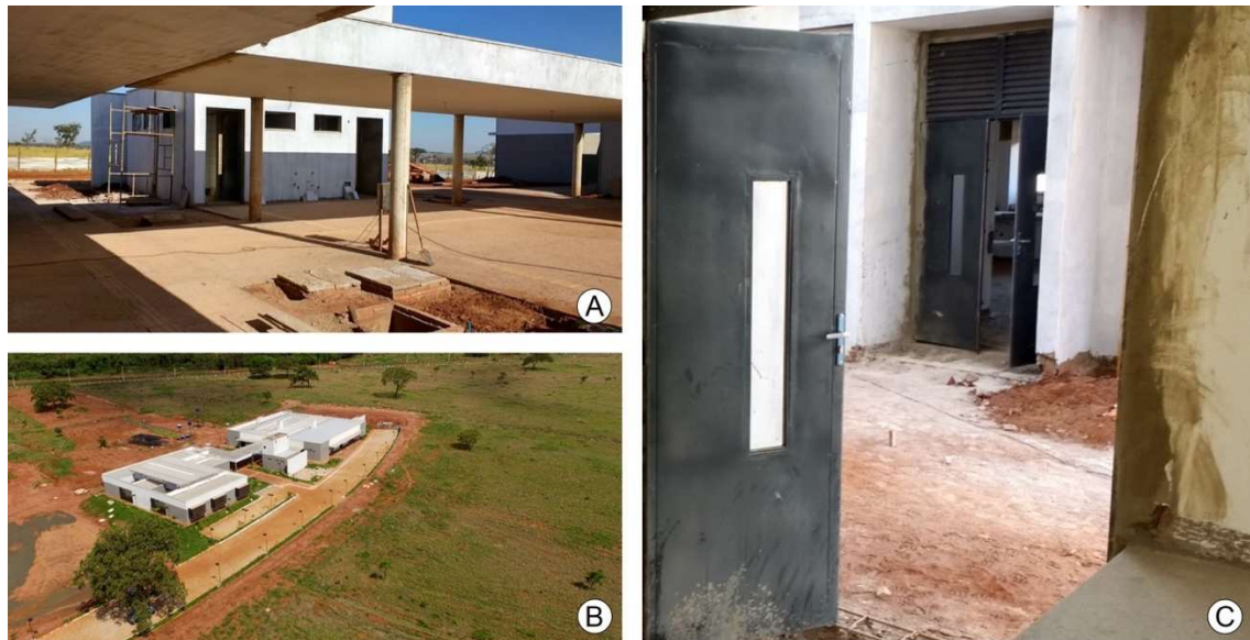
Figura 9. A: CT-Infra 3 em construção 2015; B: Vista aérea do CT-infra 2 e 3 em 2016; C: LABEC em construção.
