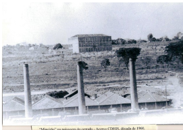
Figura 23: Foto do prédio da Faculdade Federal de Engenharia no Santa Mônica (acervo CDHIS)
