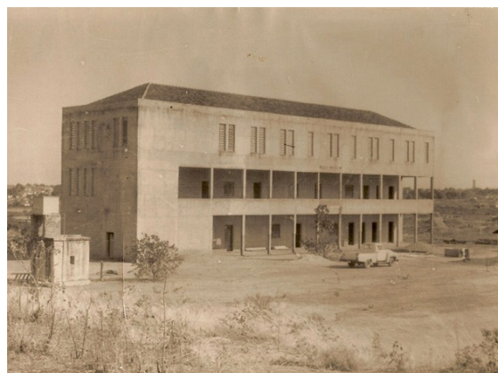
Figura 31: Foto do prédio que a faculdade ocupou após sua criação (Acervo CDHIS)
