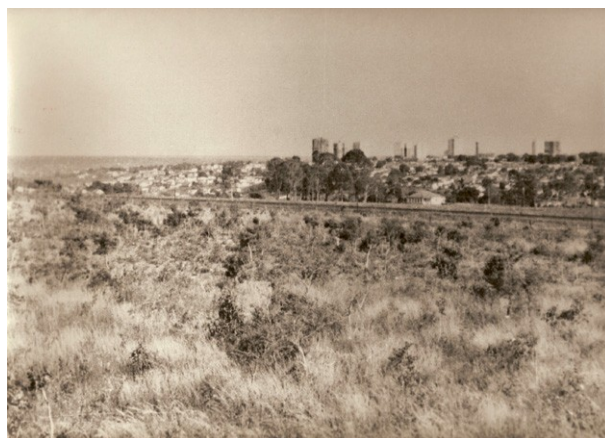
Figura 24: Foto da vista do Mineirão (prédio da Faculdade Federal de Engenharia). A figura mostra os trilhos da ferrovia Mogiana, onde hoje passa a avenida João Naves de Ávila (Acervo CDHIS).
