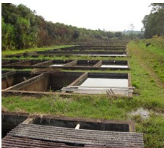
Figura 57: Foto dos tanques que eram utilizados para piscicultura (PRIETO, 2005)
