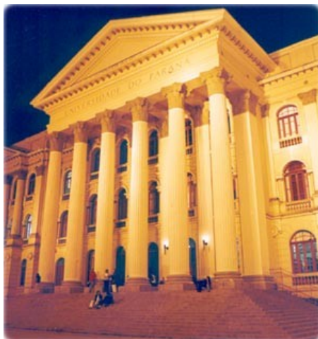
Figura 2: Foto do prédio da Universidade Federal do Paraná. Fonte: http://www.ufpr.br
