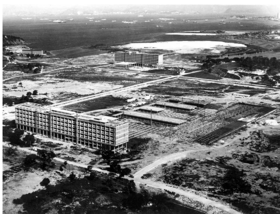
Figura 10: Foto da construção de edifícios na Cidade Universitária da UFRJ (idem)
