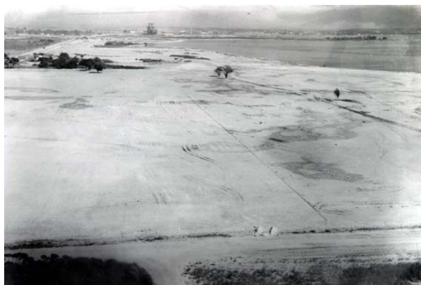
Figura 9: Foto do aterramento do conjunto de ilhas na baía Guanabara que deu origem à Ilha do Fundão. Fonte: idem
