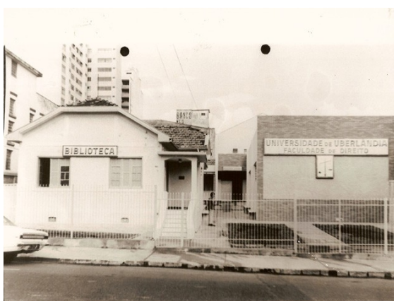
Figura 18: Foto do prédio da Faculdade de Direito na década de 1970 (Arquivo CDHIS)
