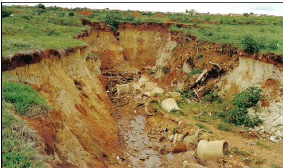
Figura 11: Reativação da erosão (voçoroca) no ano de 1998 com destruição parcial da galeria pluvial.
