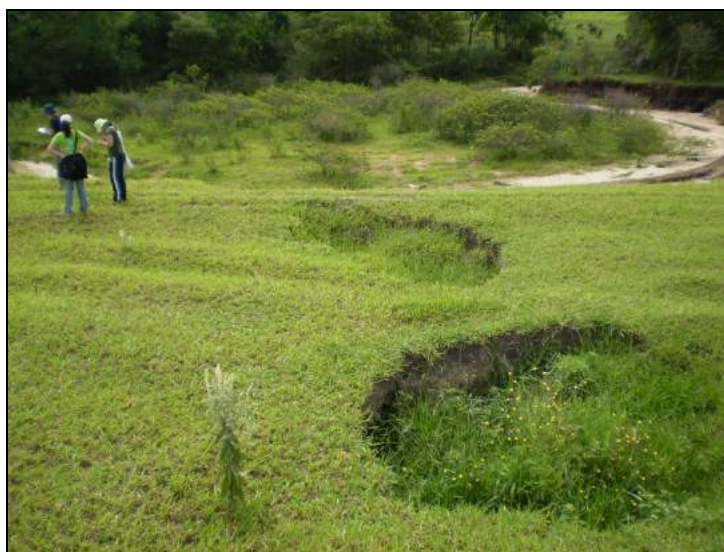
Figura 61: Colapso na estação chuvosa. Autor: GIFFONI, S. Data: 16 jan. 2009.
