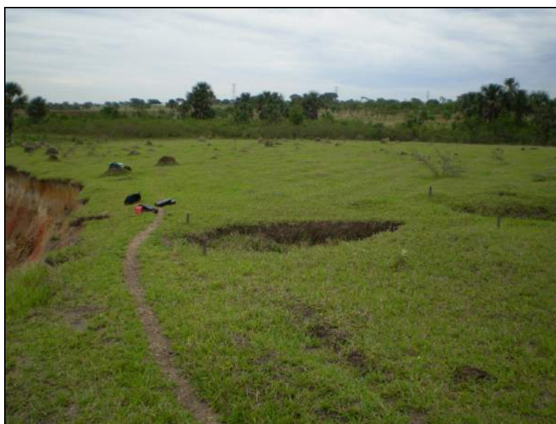
Figura 62: Colapso na estação seca. Autor: GIFFONI, S. Data: 06 out. 2009.
