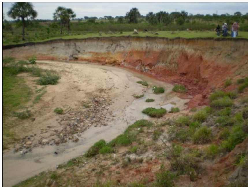
Figura 20: Visão da área mais ativa da erosão em outubro de 2009. Autor: GIFFONI, 2009.
