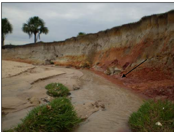
Figura 59: Vista do perfil 4 onde ocorre o piping. Autor: GIFFONI, S. Data: 06 out. 2009.
