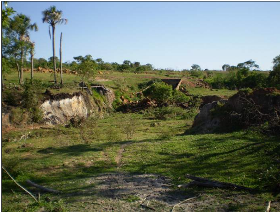
Figura 30: Aspecto da cabeceira do córrego Campo Alegre. Atentar para a erosão presente na área. Autor: GIFFONI, S. Data: 23 out. 2008.
