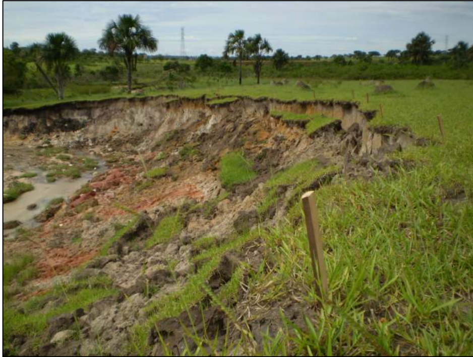
Figura 32: Fixação de estacas na borda da erosão. Autor: GIFFONI, S. Data: 18 jan. 2009.
