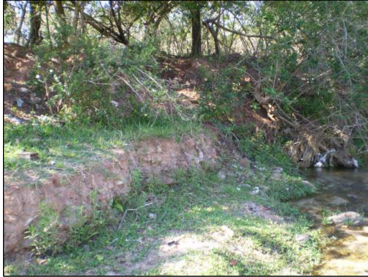
Figura 22: Resíduos acumulados no talvegue constituindo um banco métrico de assoreamento. Autor: GIFFONI, S. Data: 23 out. 2008.
