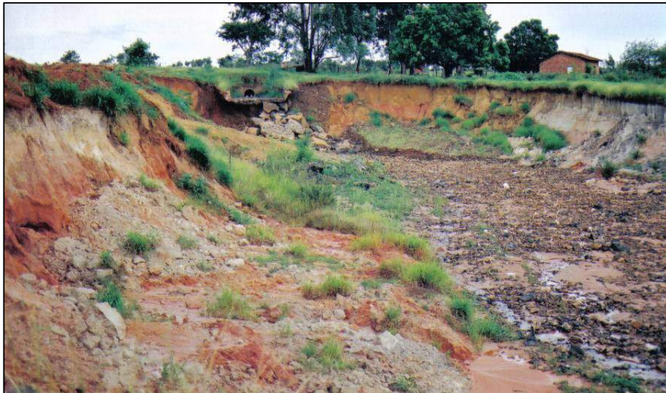
Figura 14: Segundo ponto de lançamento de águas pluviais. Atentar para a extensão da feição erosiva decorridos 4 anos após o seu início. Autor: NISHIYAMA, 2003.
