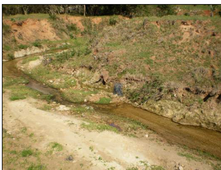
Figura 67: Banco de materiais carreados. Autor: GIFFONI, S. Data: 23 out. 2008.
