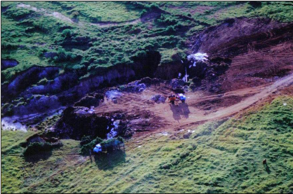
Figura 10: Detalhe do aterramento da voçoroca na porção de cabeceira do córrego Campo Alegre. Autor: NISHIYAMA, 1997.
