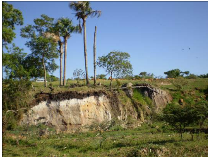
Figura 26: Extinção da palmeira buriti por falta de umidade ou queda de talude. Autor: GIFFONI, S. Data: 23 out. 2008.
