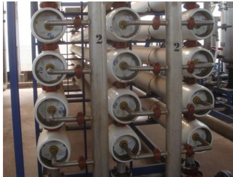
Figura 4: Membranas da osmose reversa
