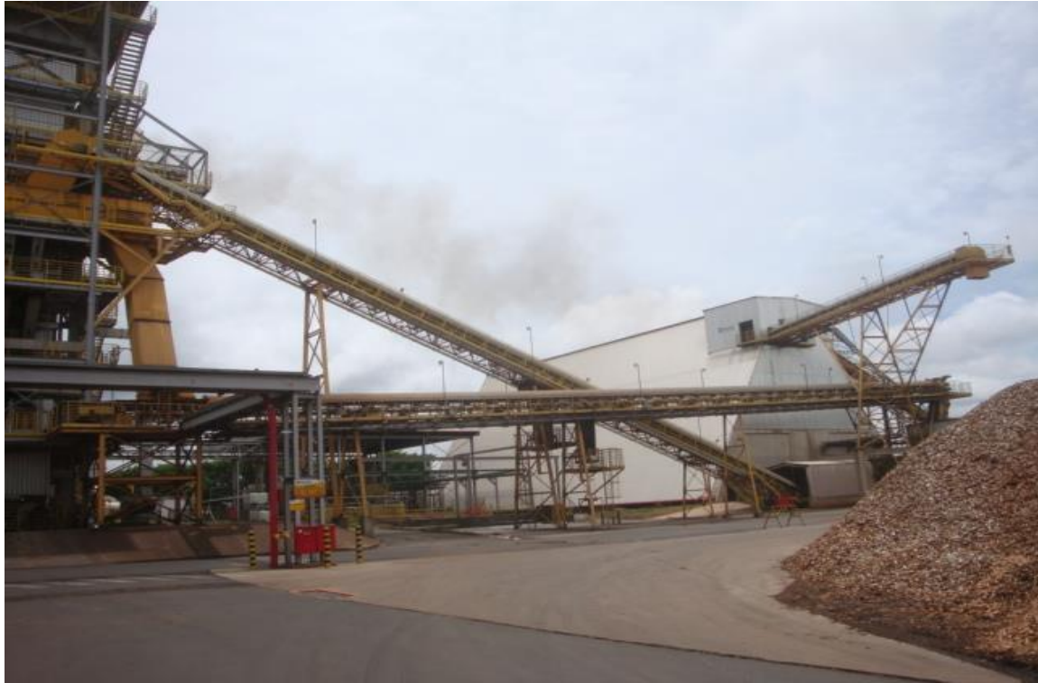
Figura 9: Pátio da caldeira
