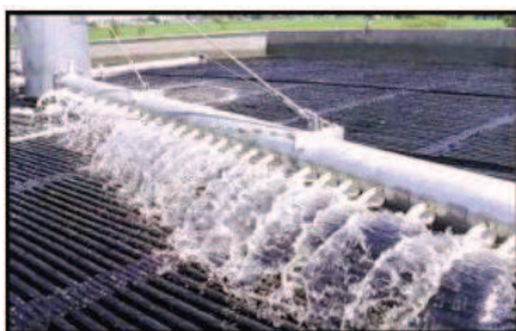
Figura 24 – Distribuidor rotativo do afluente
