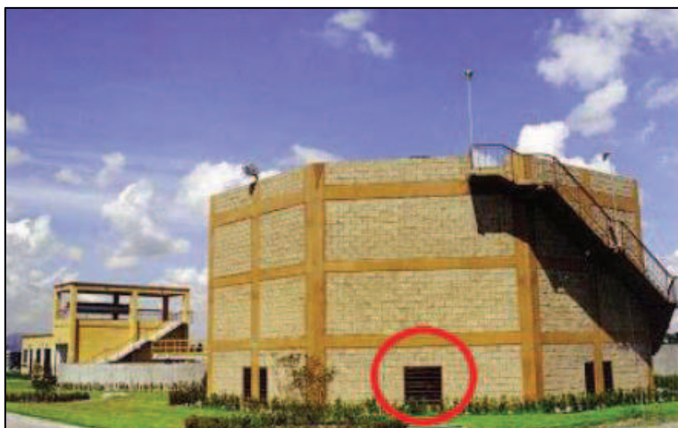
Figura 27 – Filtro biológico – detalhe da entrada de ar
