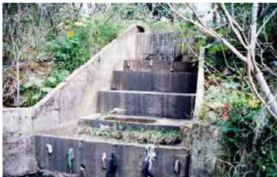
Figura 17 – Vista Frontal do Dissipador com bacia de mergulho, Bairro Jardim Brasília, Córrego Buritizinho.
