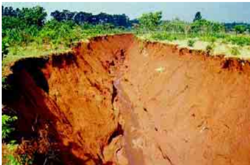
Figura 6 – Voçoroca do Bairro Cruzeiro do Sul, seu início se dá próximo das árvores mais altas, ao fundo da foto, a partir de um lançamento de rede de drenagem sobre solo. Foto: Ozanam, F. – 2003.
