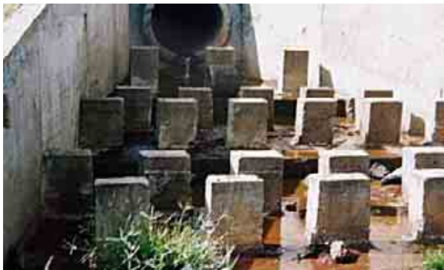
Figura 13 – Dissipador tipo Ressalto Hidráulico, muito utilizado em Uberlândia Foto: Peres, R.H.B. - 2004
