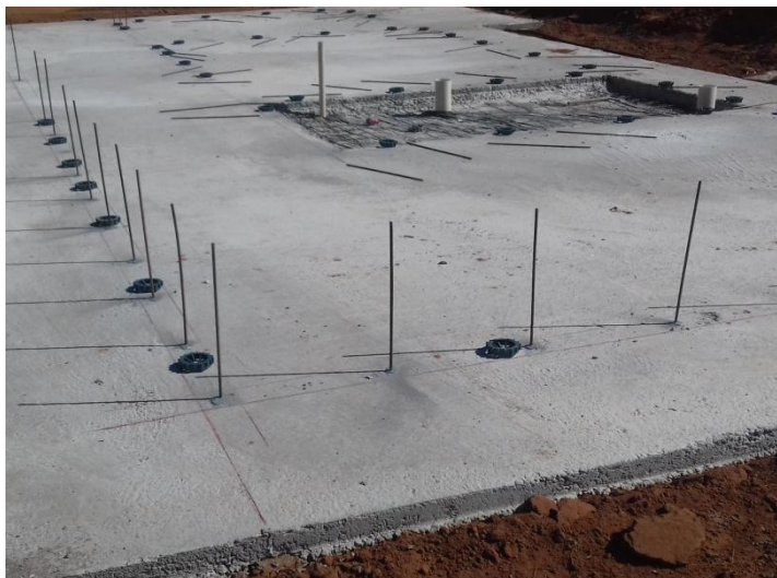
Figura 7 - Marcação no radier, espaçadores de plástico e armaduras de espera para as paredes
