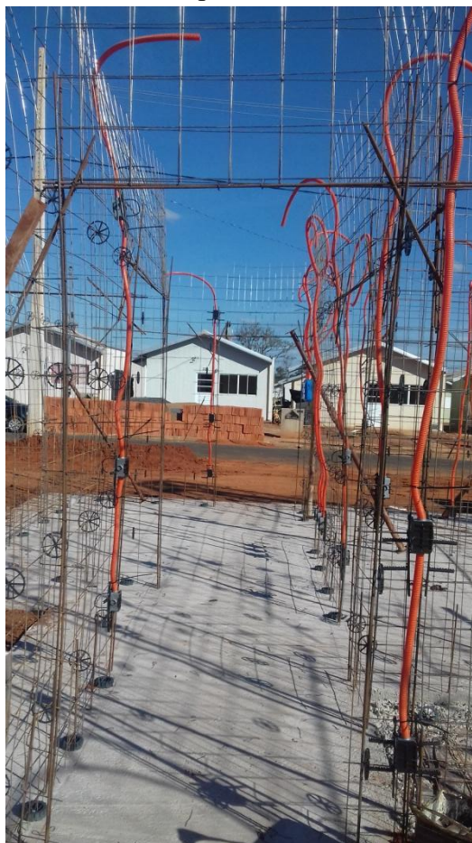
Figura 8 - Telas, espaçadores e eletrodutos posicionados para colocação das fôrmas nas paredes
