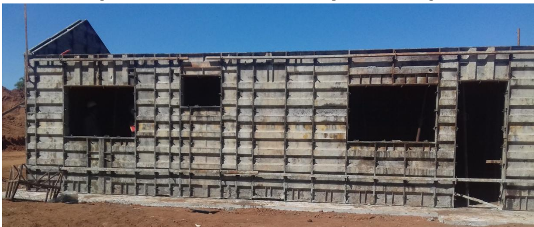
Figura 9 - Fôrmas de alumínio fixadas para a concretagem
