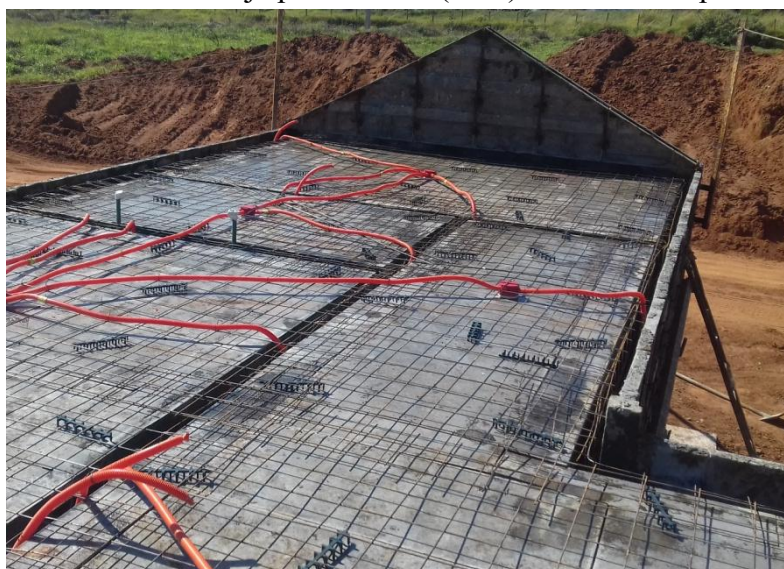
Figura 10 - Armadura da laje posicionada (telas) e eletrodutos para instalações
