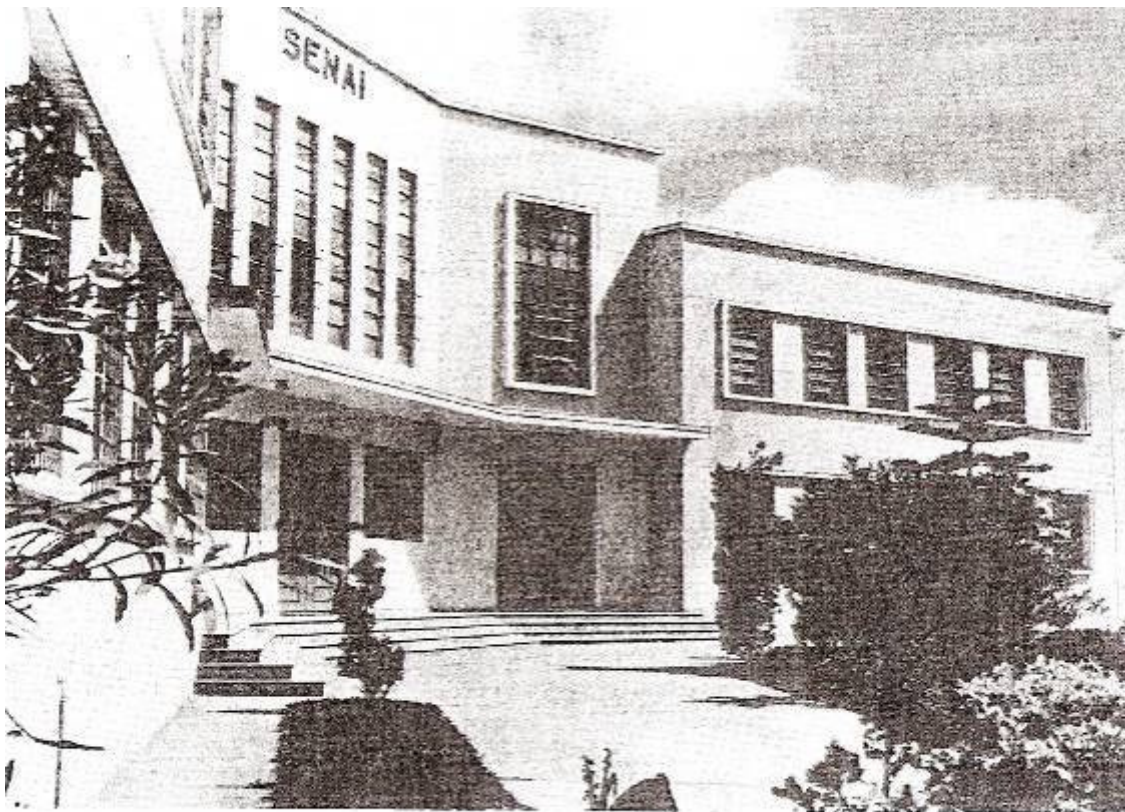
Fachada da primeira unidade do Senai em Minas Gerais. "Escola de Aprendizagem de Belo Horizonte" – hoje Centro de Formação Profissional Américo Renê Giannetti, em funcionamento desde 16/11/44
