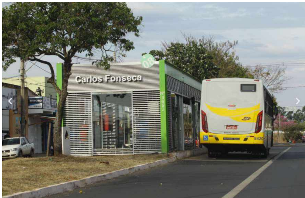
Figura 7 – Estação do Corredor Segismundo Pereira.
