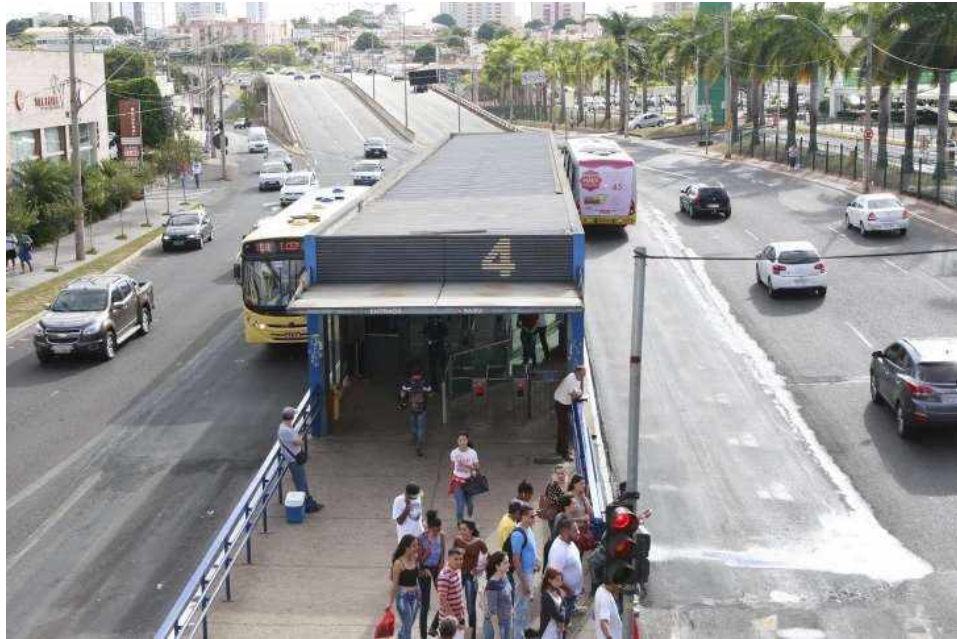
Figura 6 – Estação do Corredor João Naves de Ávila.
