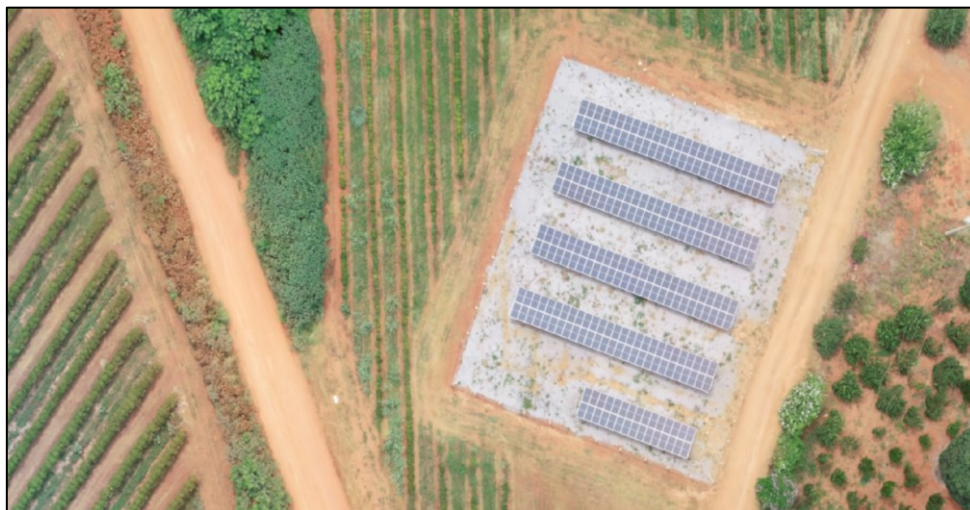
Figura 25 – painéis solares identificáveis.
