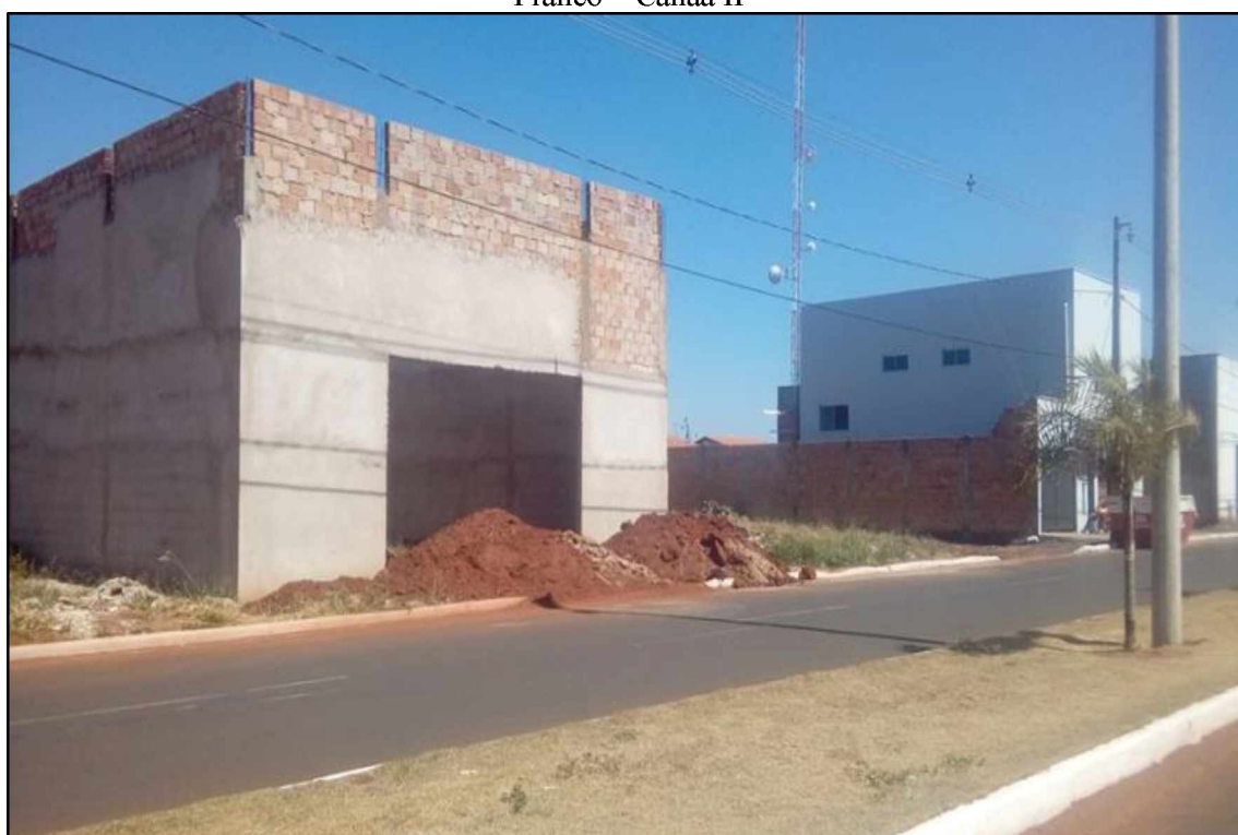
Figura 25. Edificação com características comerciais em construção na Avenida José Gouveia Franco – Canaã II
