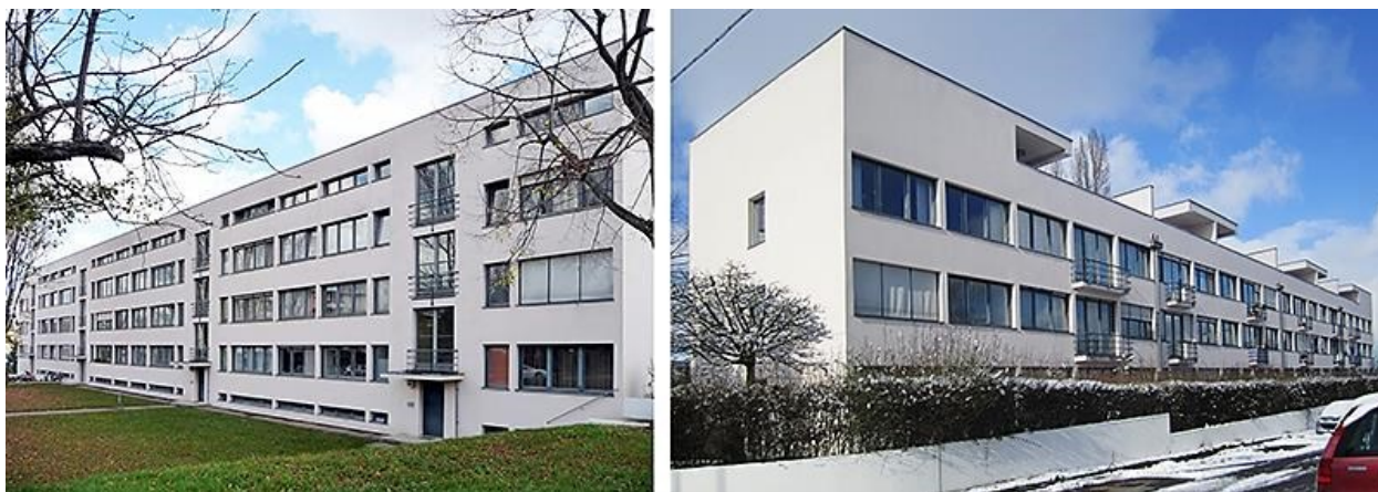
Figura 2: Edifício de apartamentos de Mies van der Rohe
