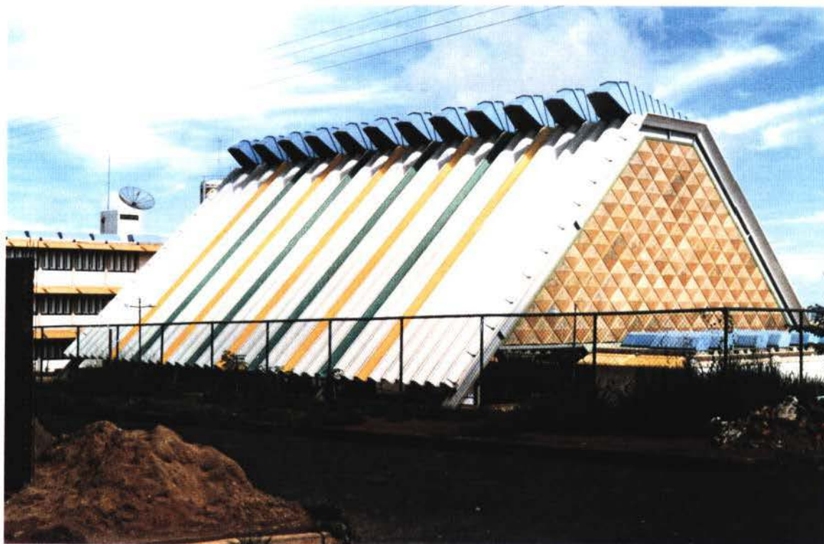
Foto: 3 - Vista parcial da Quadra de Esportes - CAIC Laranjeiras.
