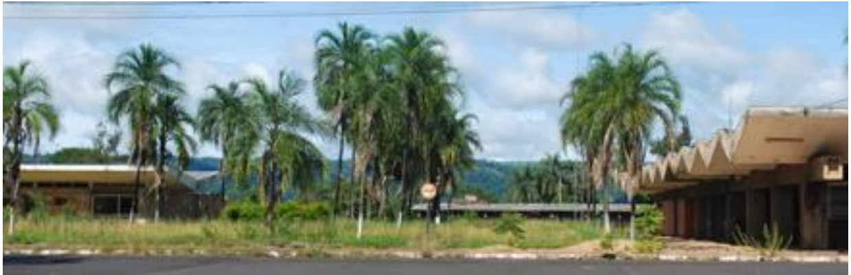
Vista do Conjunto: Centro Comercial, Administração e Escola ao fundo. Fonte: Arquivo da pesquisa.
