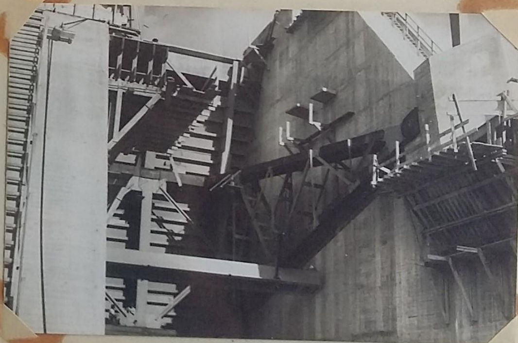
Vertedor - Vão nº 1 - Montagem da Comporta de Setor
