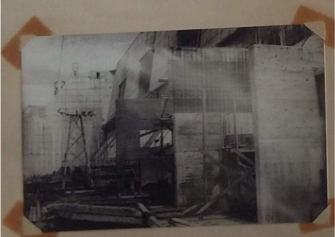
Galeria de Barramentos - Paredes dos Tranfor- madores
