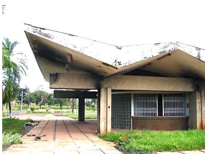
Detalhe da cobertura e área de lojas. Fonte: Arquivo da pesquisa.
