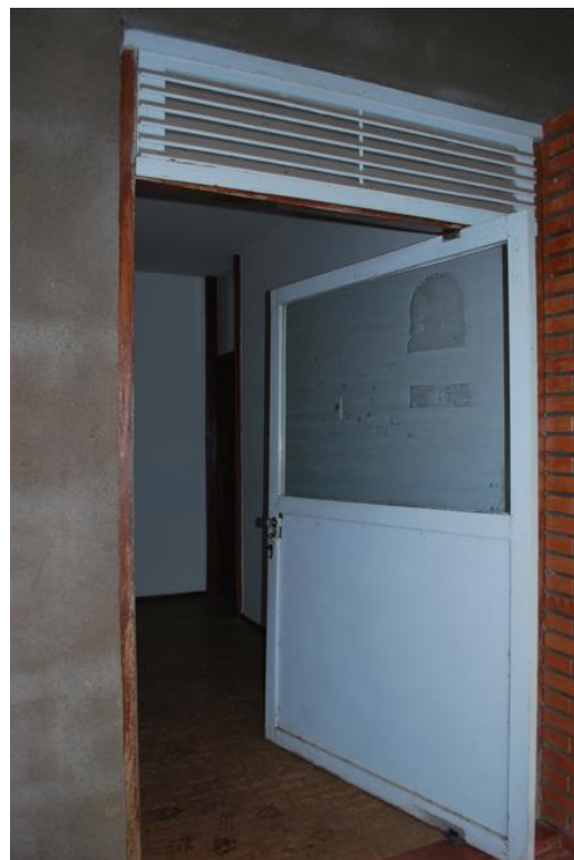
Detalhe da porta pivotante. Fonte: Arquivo da pesquisa.
