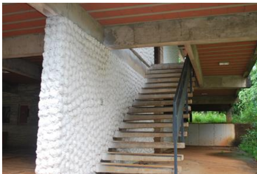
Detalhe da escada que acessa o terraço. Fonte: Arquivo da pesquisa.
