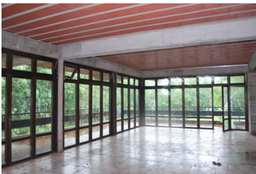
Vista interna da área coletiva. Fonte: Arquivo da pesquisa.
