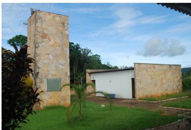
Vista do vestiário. Fonte: Arquivo da pesquisa.
