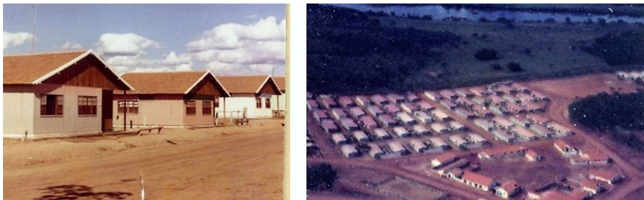
Figura 20 Habitações temporárias erguidas para os empreiteiros que trabalham na construção da UHE Jaguara. Fonte: Setor de Memória CEMIG- Belo Horizonte, 2016.
