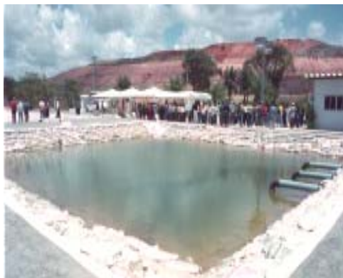
FIGURA 2.14: Lagoa de recirculação das células.
