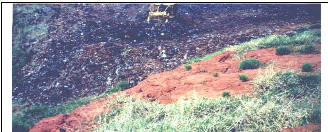
FIGURA 2.22: Conformação da célula do aterro com o emprego de trator de esteira.
