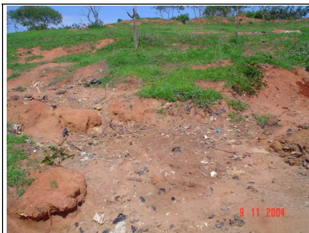
FIGURA 2.32: Reaparecimento do lixo em decorrência da erosão nas células do aterro
