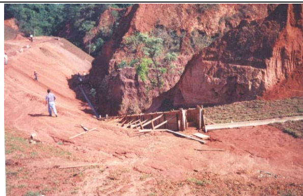
FIGURA 2.27: Trabalho de retaludamento da porção inferior da voçoroca.
