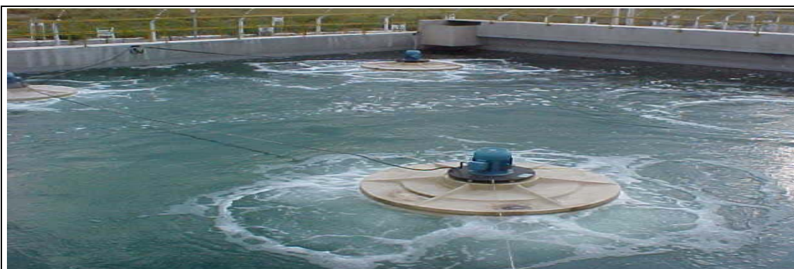
FIGURA 2.10 – Esquema de lagoas de aeração.
