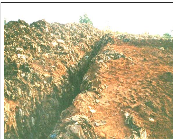
FIGURA 2.23: Trancheiras abertas para implantação dos drenos de gases e chorume, tipo espinha de peixe.
