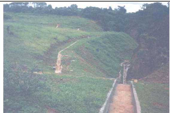
FIGURA 2.28: Aspectos gerais da área após a conclusão do projeto de remediação.
