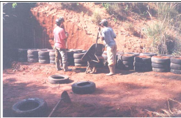
FIGURA 2.25: Vista da construção do barramento com a utilização de pneus.
