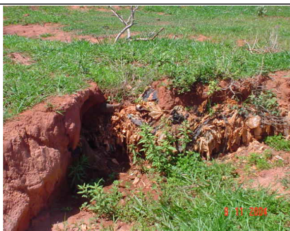
FIGURA 2.33: Lixo exposto em uma das porções das células.
