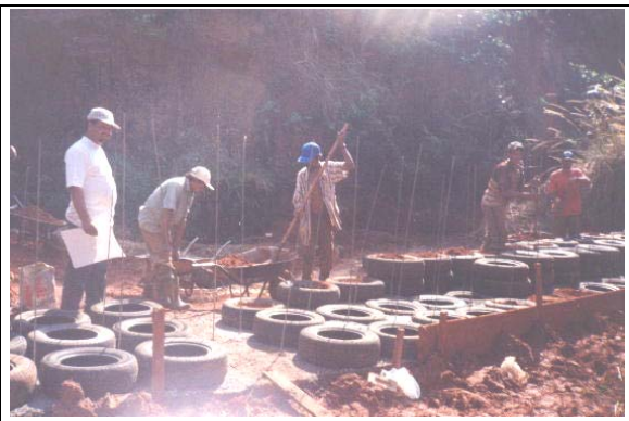
FIGURA 2.26: Construção de barramento em uma outra seção da voçoroca.
