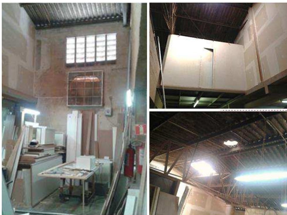
Figura 34 - Iluminação, ventilação e teto
