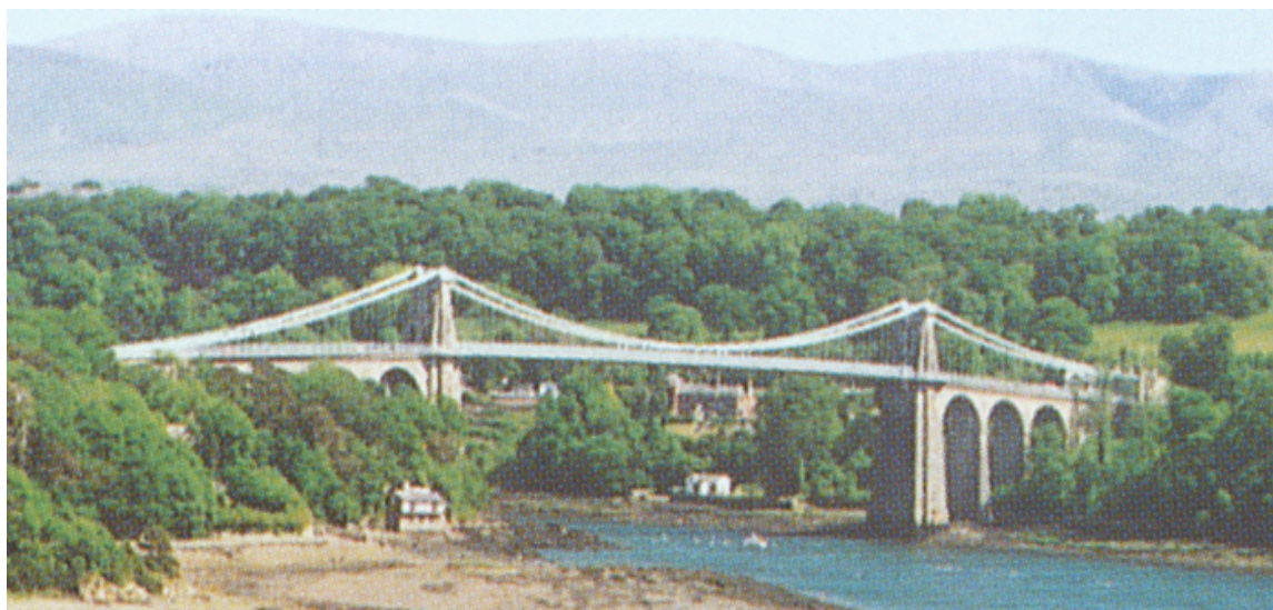
Figura 7 - Ponte construída por Thomas Telford, em 1826
