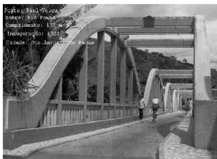
Figura 57 - Ponte Raul Veiga
