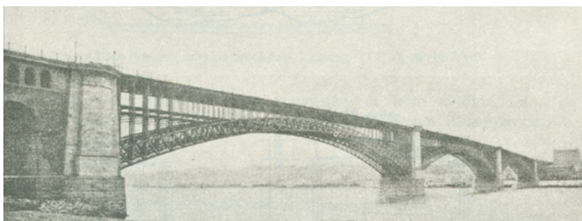
Figura 10 - Ponte de Eades, St. Louis Fonte: Pfeil (1982).
