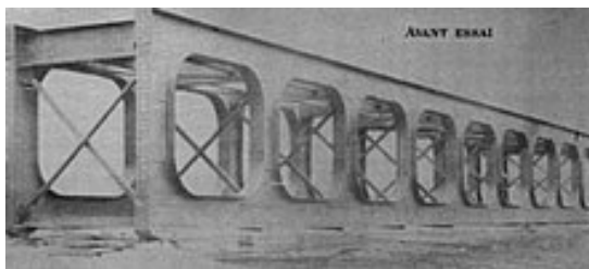
Figura 64 – Viga Vierendeel antes do ensaio
