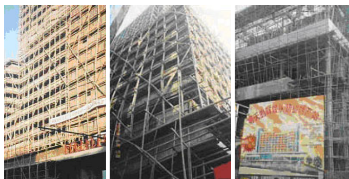
Figura 33 - Utilização do Bambu como andaimes, na China Fonte: www.vmtubes.com.br (2005).
