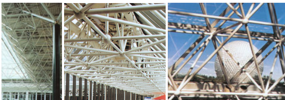
Figura 19 - Treliça do tipo espacial Fonte: Meyer (2002).
