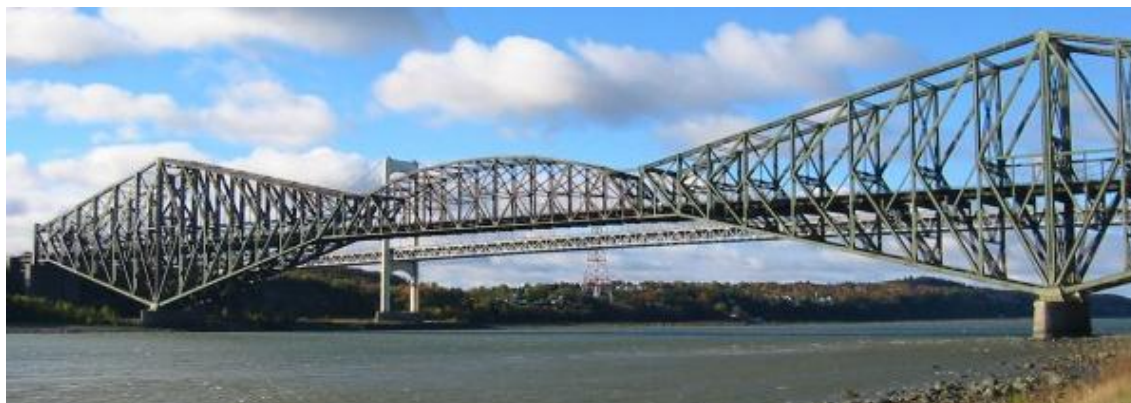
Figura 12 - Ponte sobre o rio São Lourenço (1917), Quebec Fonte: http://de.structurae.de/structures/data/photos.cfm?ID=s0000480 (2002).
