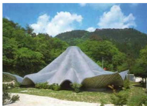
b) Fôrma permanente em laje de concreto
