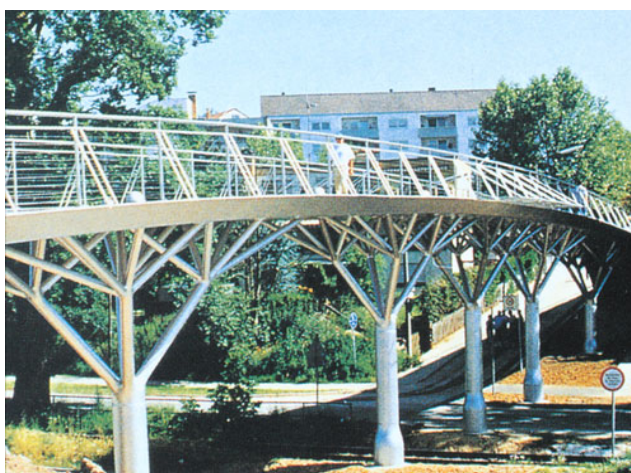
Figura 31 - Passarela Fonte: Meyer (2002).
