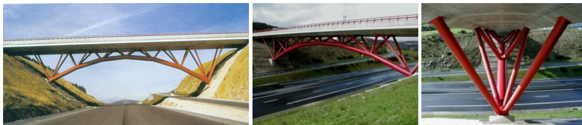
Figura 36 - Ponte de Antrenas
