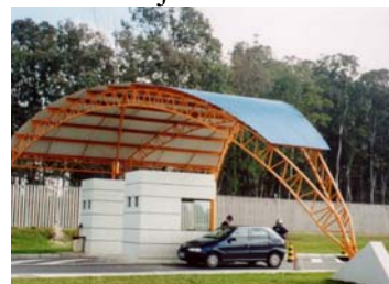
d) Guarita na entrada de acesso em Curitiba/ PR
