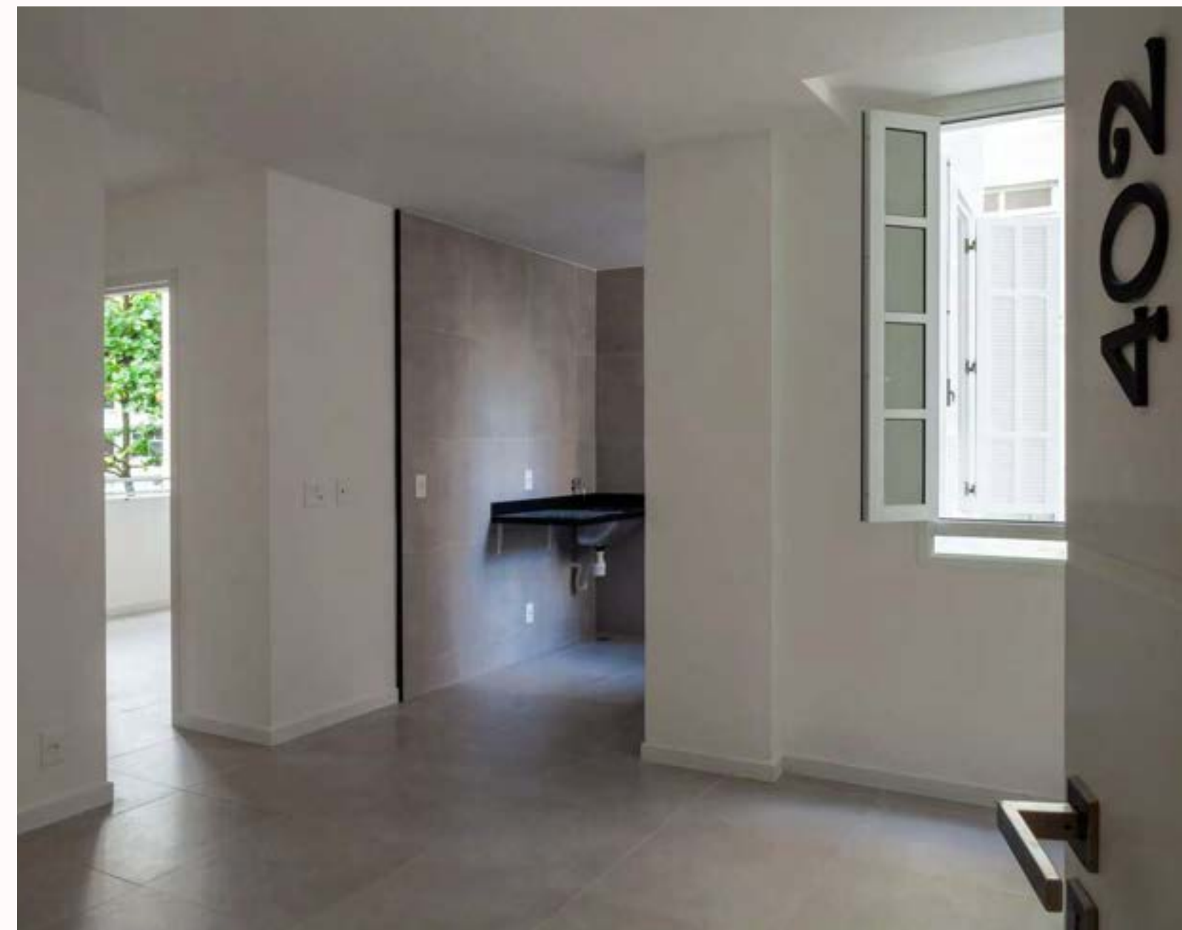
Figuras 42. Fotografia de um dos apartamentos do edifício Paysandu após a reforma. Fonte: Cité Arquitetura
