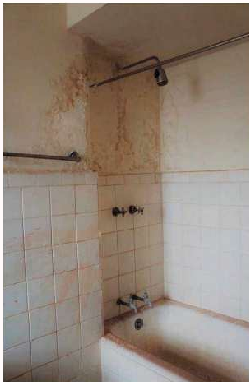
G49 Banheiro do Apto 25
