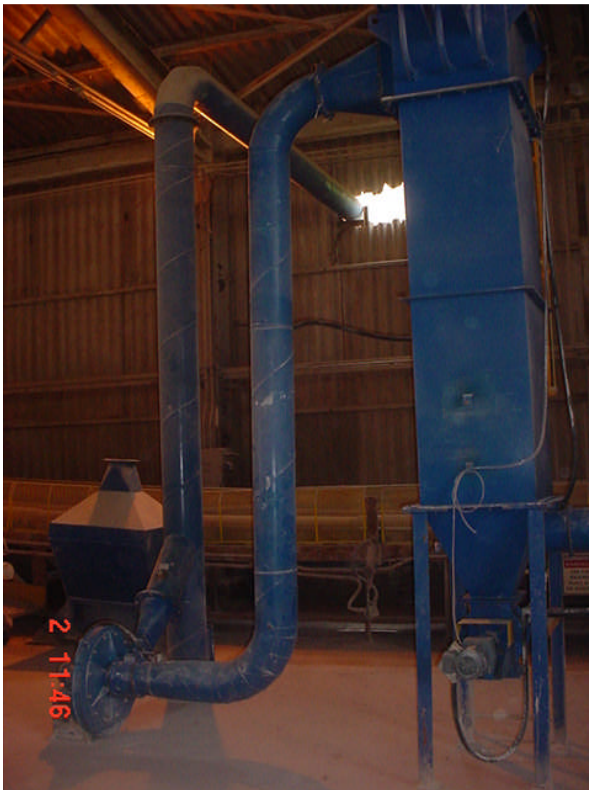
Figura A1.3- Filtro Manga e Ventilador de Ar de Fluidização
