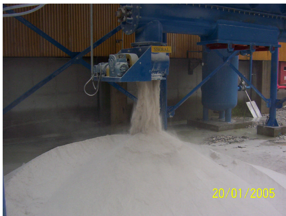
Figura A7.2- Pó Elutriado – Sistema em Operação com Alimentação de 60 Ton/h
