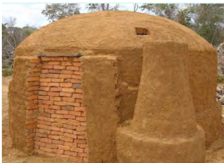
Figura 2.7 – Forno JG-AGRESTE 2,50 (FILHO, 2007)
