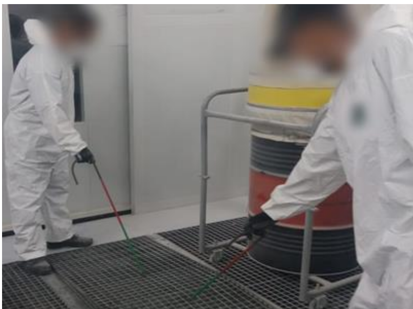
Figura 9 – Retirada das grades do solo com uso de nova ferramenta
