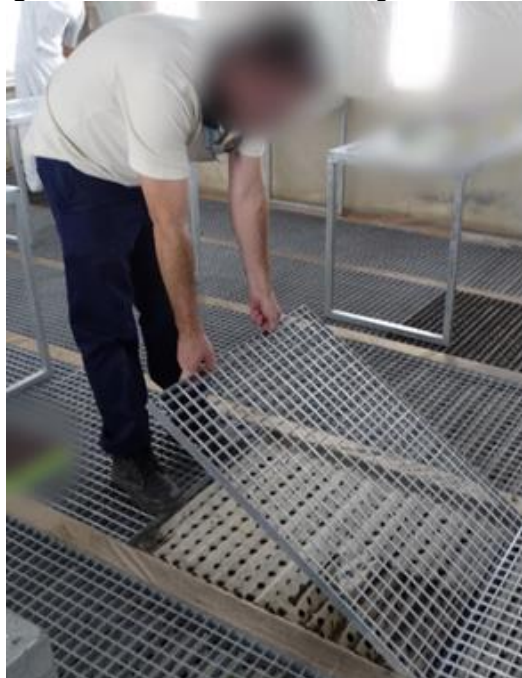
Figura 8 – Retirada manual das grades do solo
