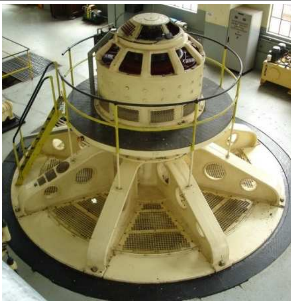
Figura 2.1 – Gerador síncrono com excitatriz acoplada ao eixo Fonte: Usina Hidrelétrica de Rasgão - EMAE
