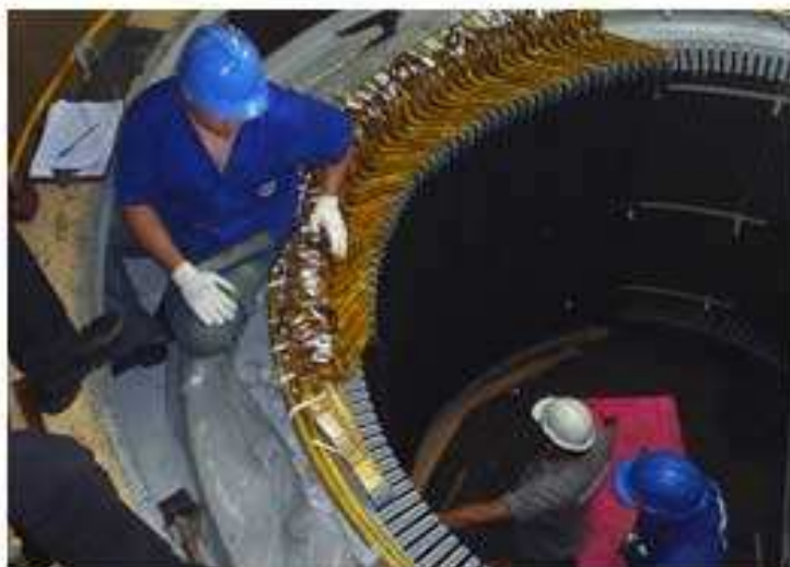
Figura 2.8- Montagem da bobinas nas ranhuras do estator Fonte: site:www.nishi.com.br
