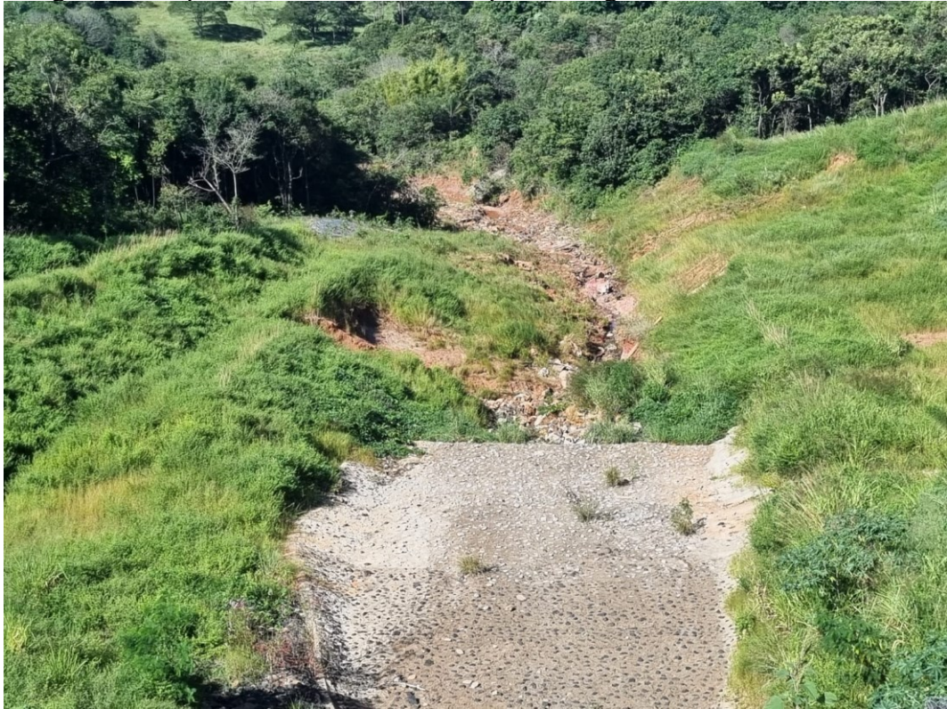
Figura 20 - Vista do local a ser colocado mais pedras, auxiliando na dissipação de energia e consequentemente diminuir o impacto da água no solo.
