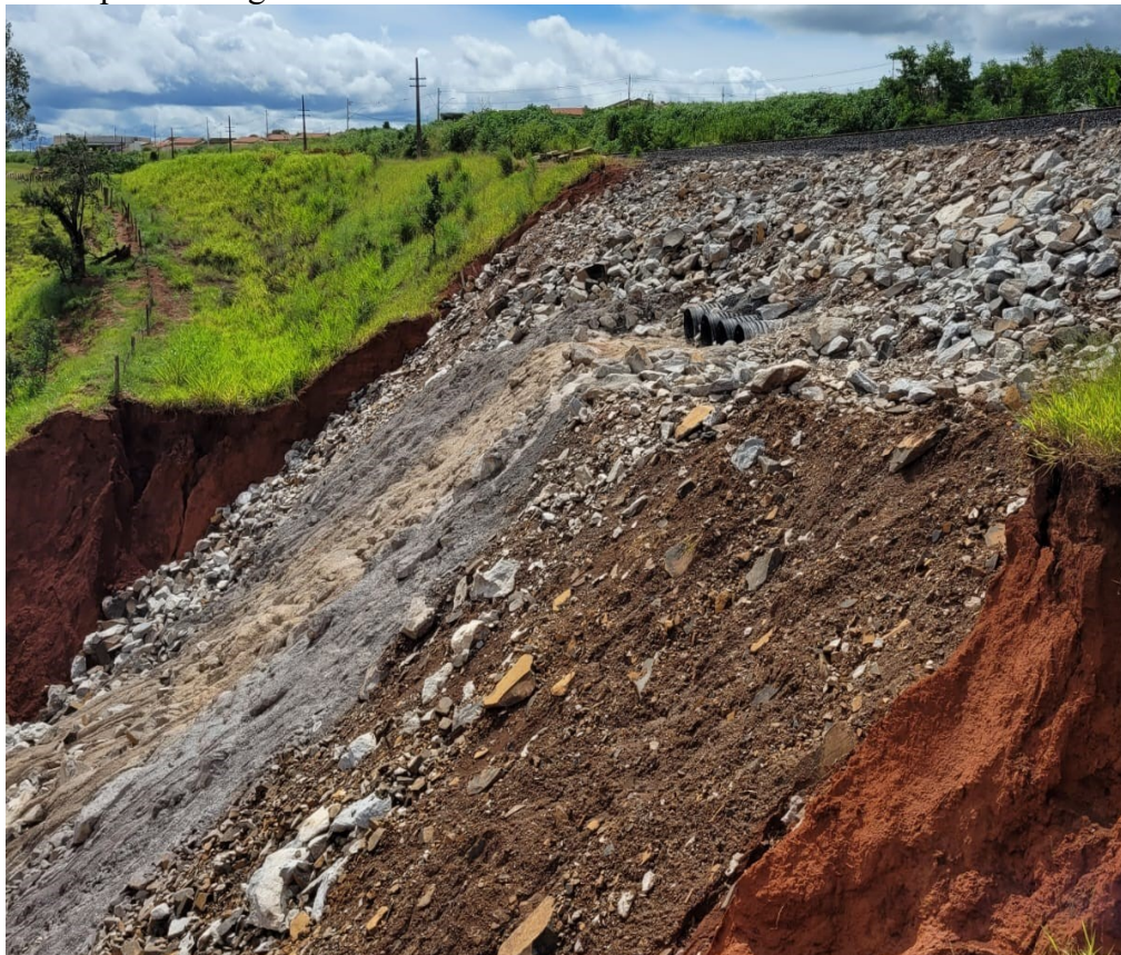
Figura 9 - Obra emergencial para restabelecimento da via férrea e a construção da estrutura hidráulica de água pluvial, localizada no bairro Millenium no município de Araguari -MG.
