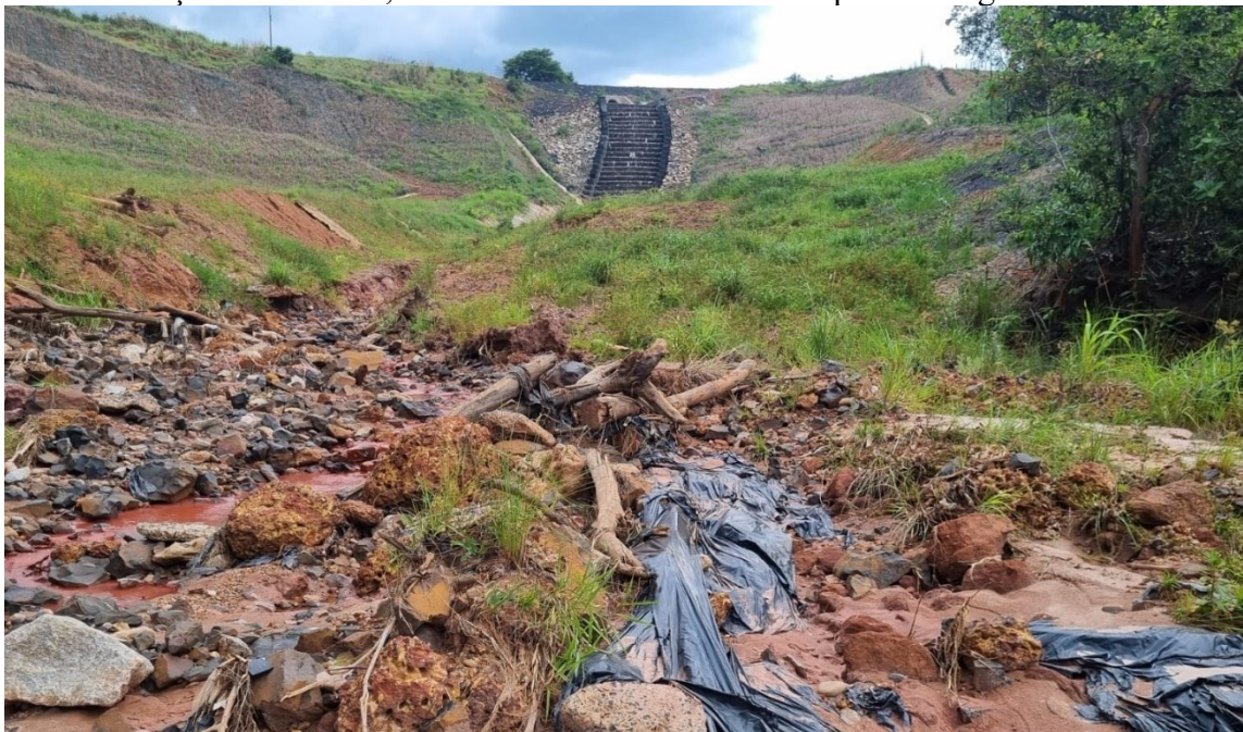
Figura 10 - Realização da construção da escada de dissipação de água pluvial e reconformação dos taludes, no bairro Millenium no município de Araguari -MG.
