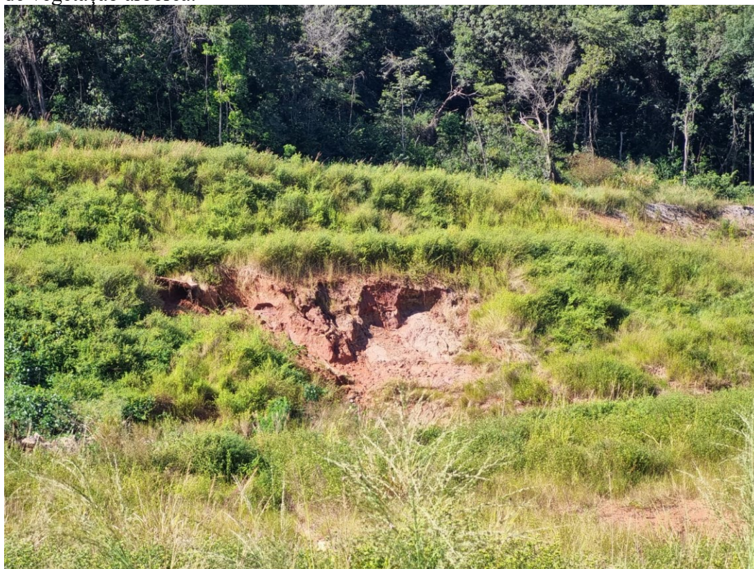
Figura 16 - Barranco exposto, devido ao fluxo de água pluvial das canaletas e a falta de vegetação arbórea.
