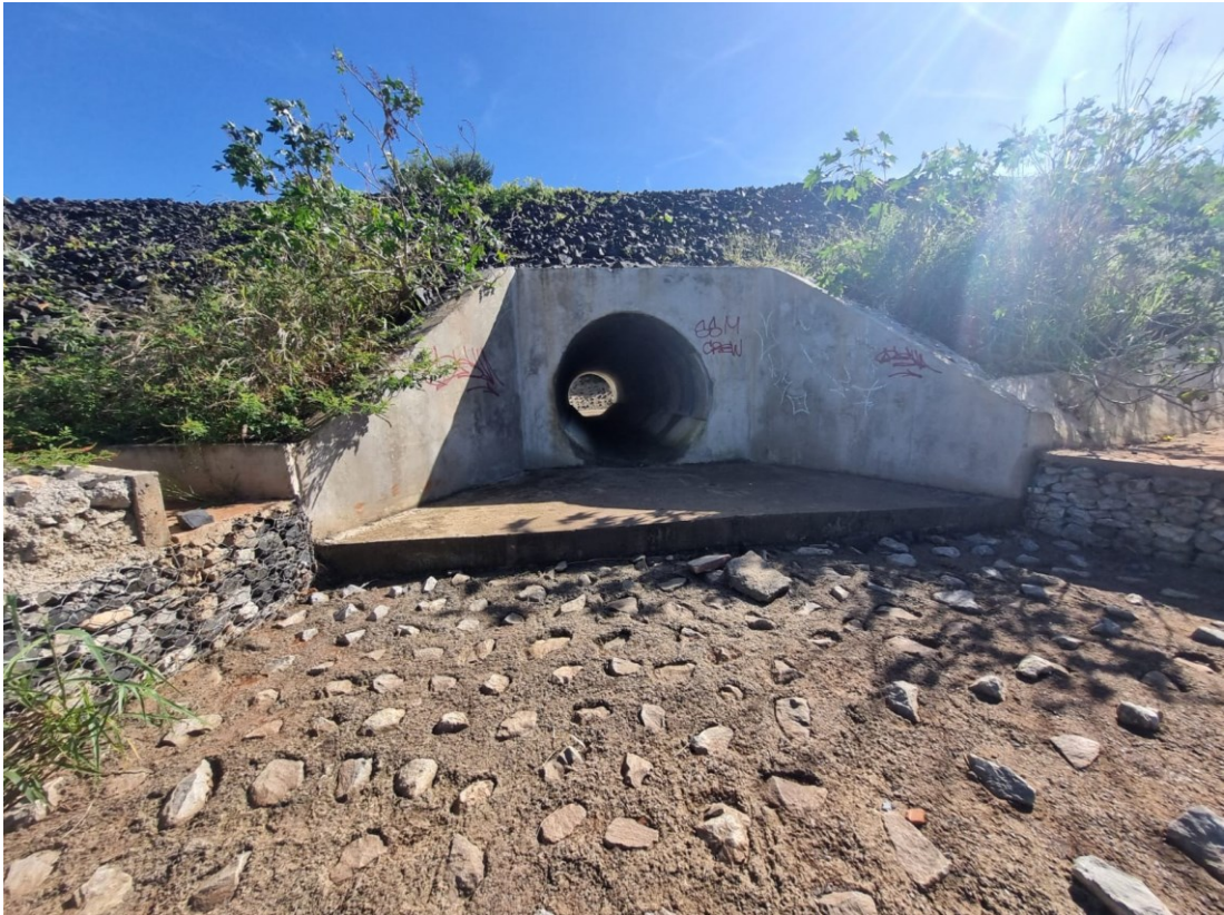
Figura 18 - Parte superior da escada de dissipação de energia, localizada abaixo da via férrea.
