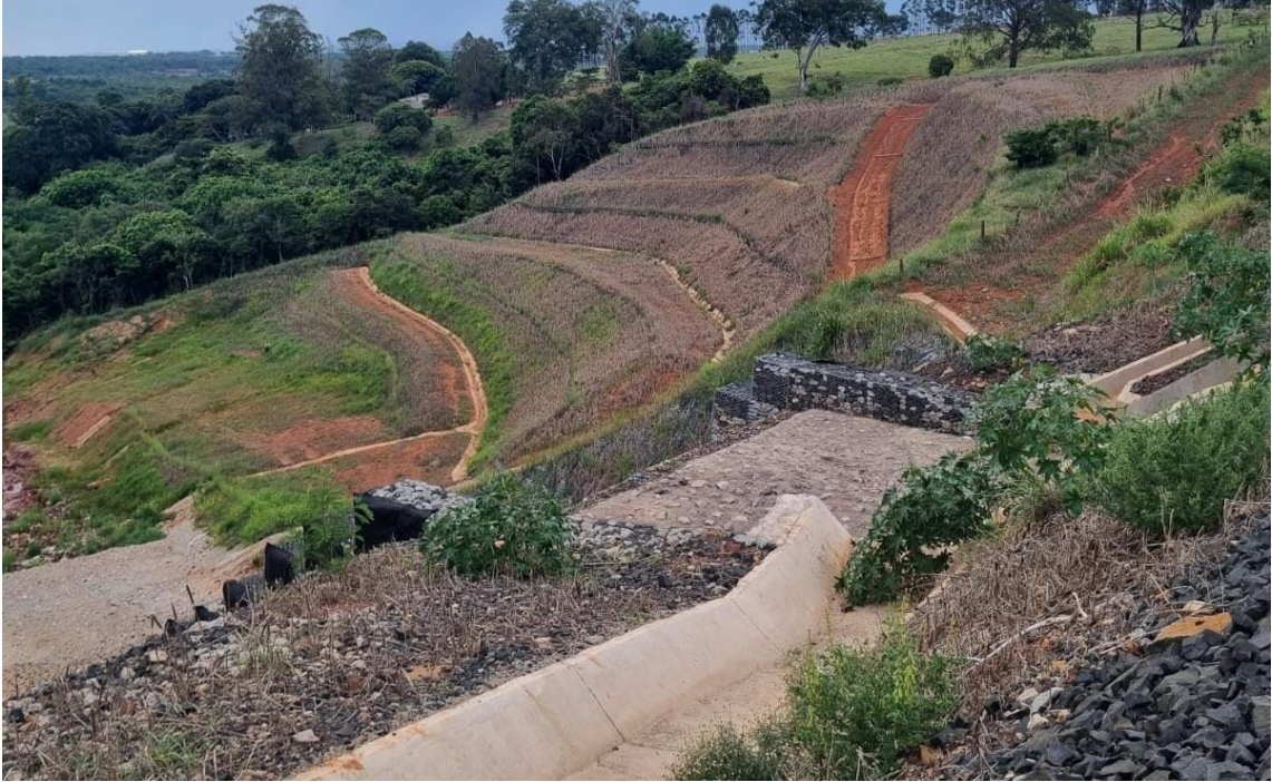
Figura 13 - Imagem da área parcial recuperada do ponto de vista físico-estrutural, com a escada de dissipação de energia de água pluvial.
