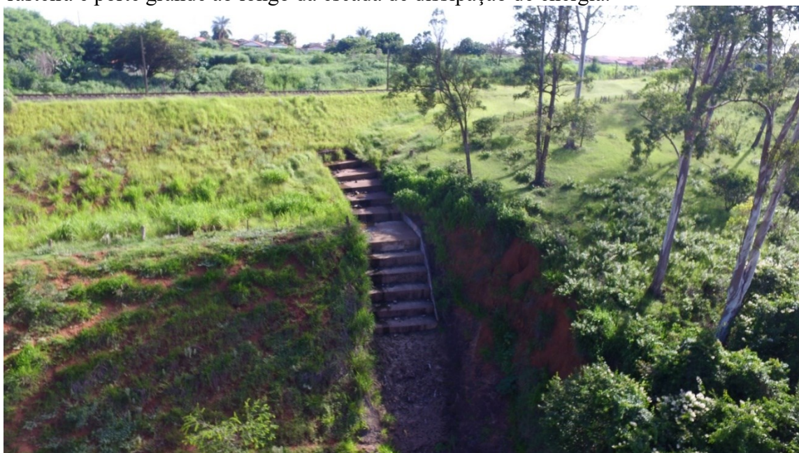
Figura 11 - Imagem de drone da aérea a jusante a via férrea, com à presença da vegetação rasteira e porte grande ao longo da escada de dissipação de energia.
