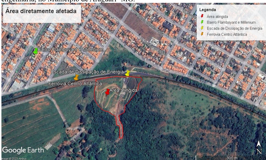
Figura 2 - Imagem aérea da área degradada (voçoroca) recuperada por meio de obra de engenharia, no Município de Araguari -MG.
