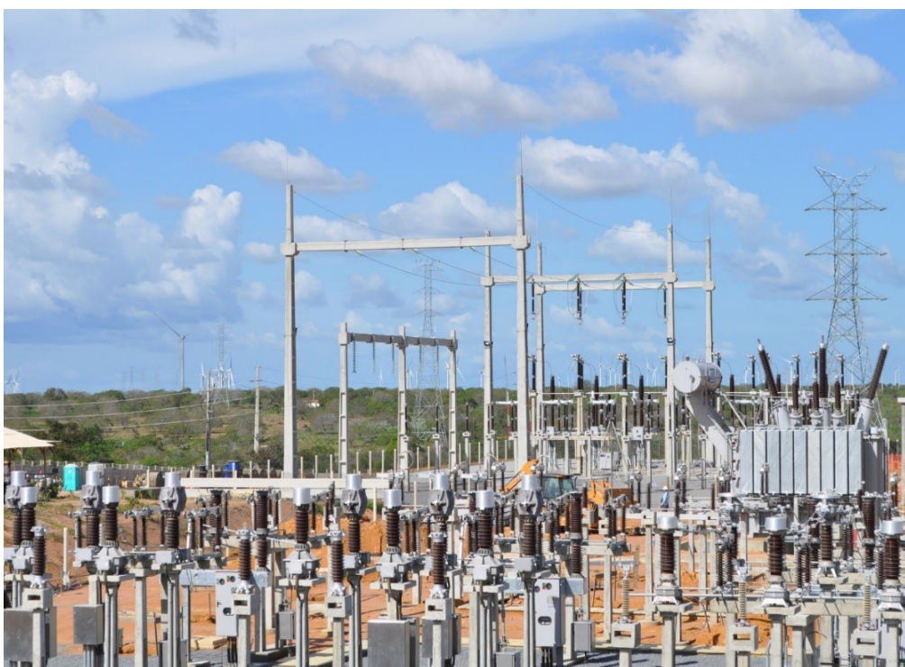
Figura 6 - Foto da subestação da Lagoa Nova II em construção
